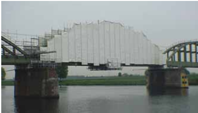
Brug bij Ravenstein ingepakt voor onderhoudswerkzaamheden
