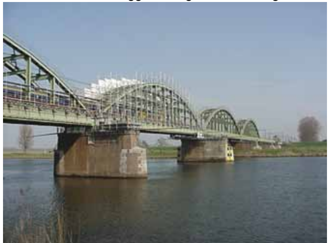
Brug over de Maas bij Ravenstein
