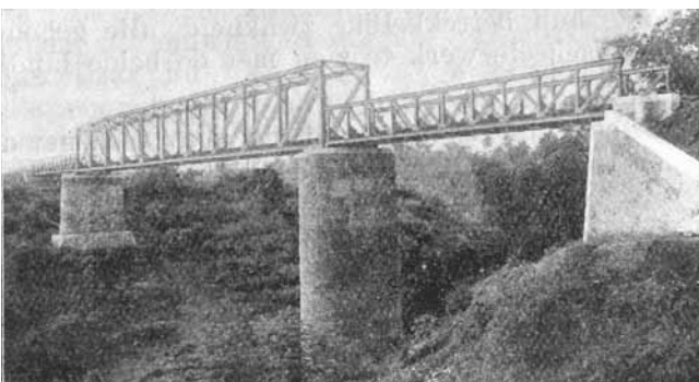
6. Aanzicht van de brug na verwijdering van de hulpbrug.
