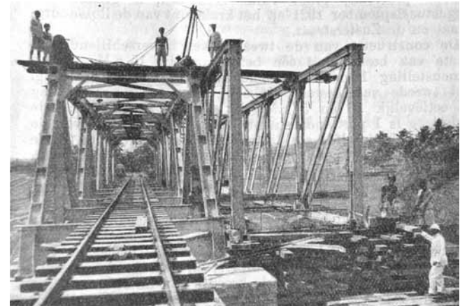
20. Demontage van een brug van 45 m.
