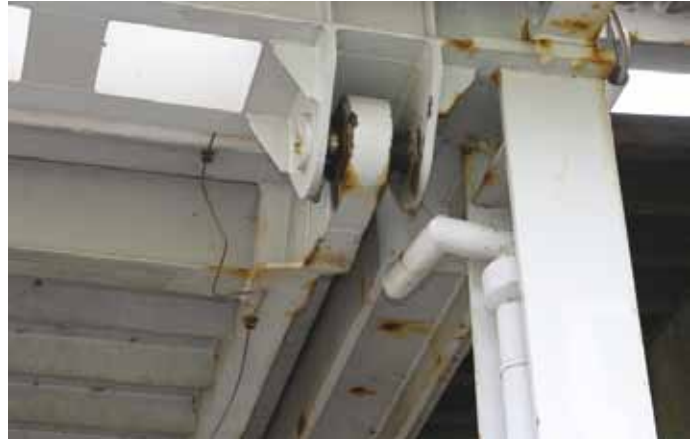
Scharnierend opgehangen dwarsdrager van het bovendeck (foto Ciska Klooster)
