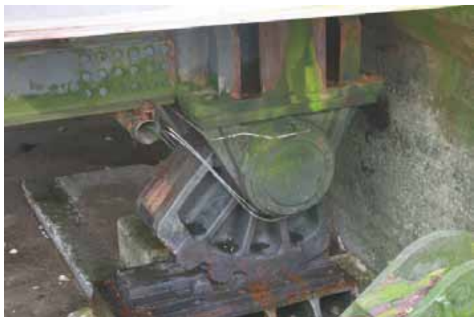
Roloplegging op het landhoofd, die ook een kleine horizontale verplaatsing mogelijk maakt (foto Ciska Klooster)
