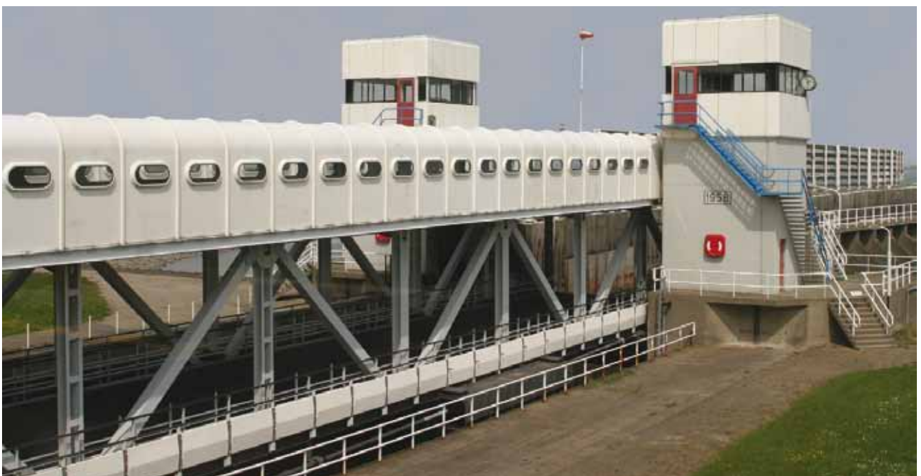
De dubbeldeks aanlegbrug tussen de heftorens (foto Ciska Klooster)
