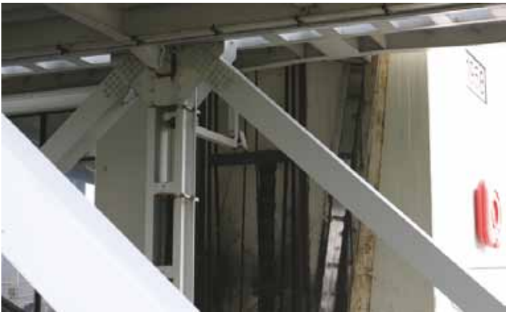
Geleiding langs de heftorens. De getrapte rail voor de noodsteunen. (foto Ciska Klooster)
