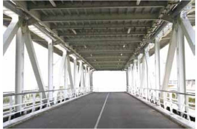
Het benedendek, de schamierend opgehangen dwarsdragers van het bovendek zijn goed te zien (foto Ciska Klooster)
