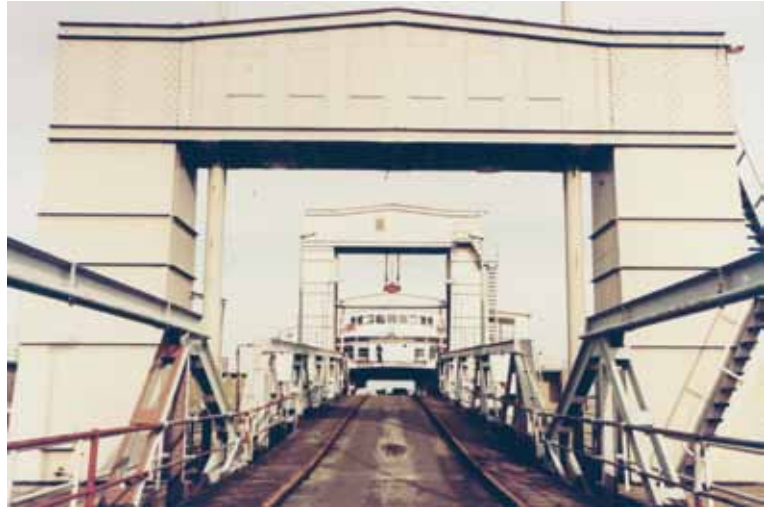
Breskens, oude aanleginrichting uit 1928 (foto RWS)
