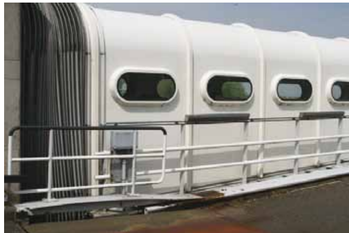
Harmonica-verbinding voor het overdekte voetpad. Op de voorgrond de overgangsplaten (foto Ciska Klooster)
