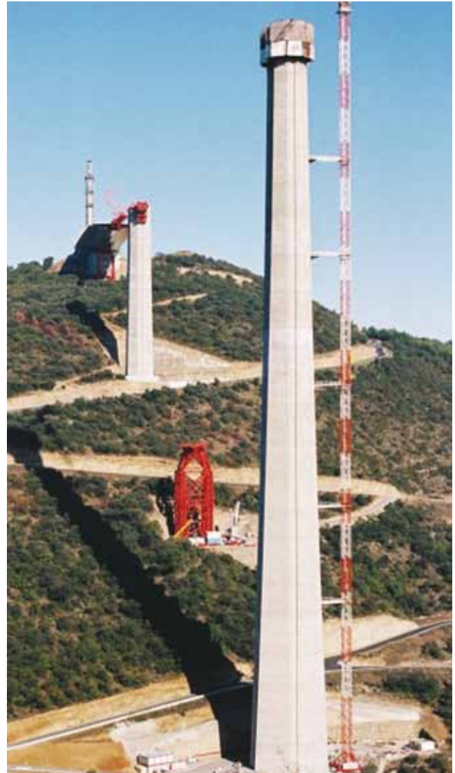
Figuur 3: bouw van de pijlers
