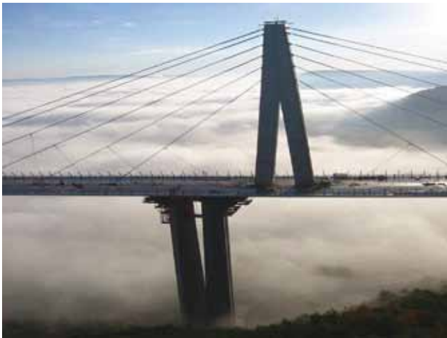
Figuur 5: de pyloon op het voorste deel van het dek, tijdens het schuiven
