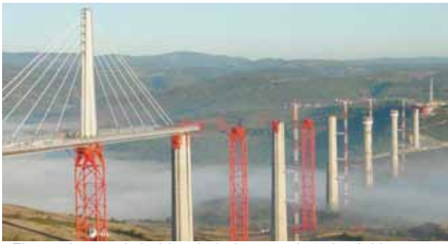
Figuur 8: vanuit beide uiteinden worden de dekken naar elkaar toe geschoven
