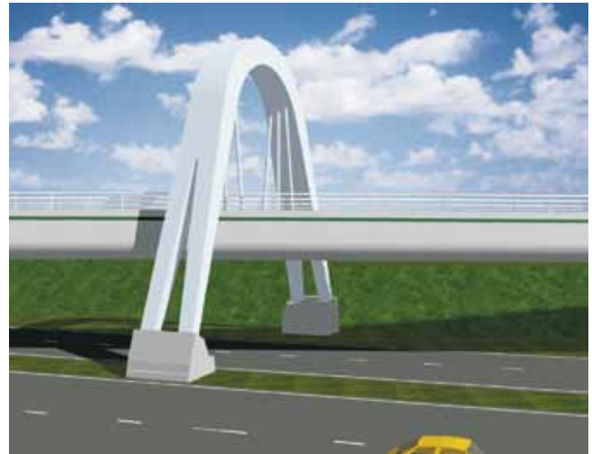
Figuur 3: Zijaanzicht stalen hangportaal
