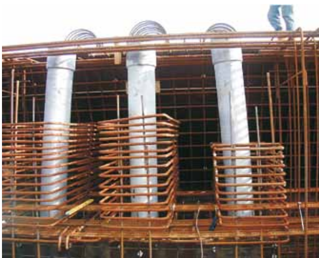
Figuur 10: De stalen doorvoeren in de trogbalk
