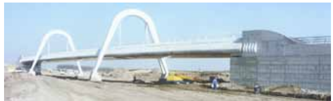
Figuur 12: Bouw van de Hangtrogbrug
