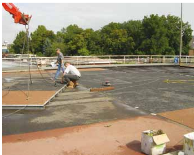
Montage van aluminium dek
