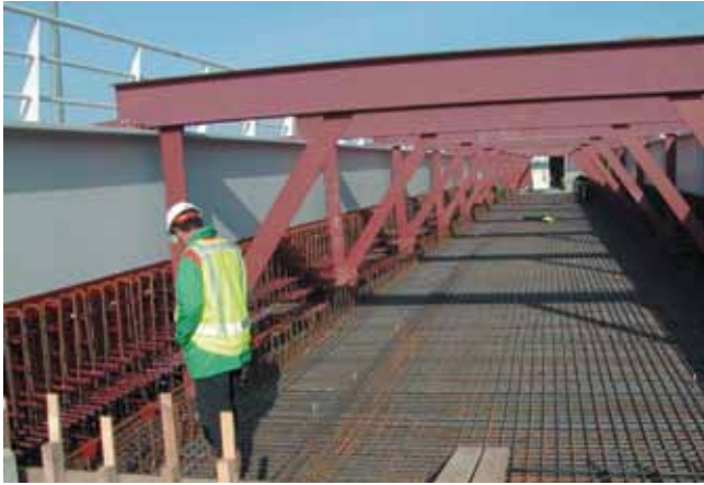
6. Hulpconstructie en wapening dek.
