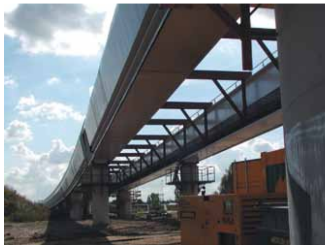
4. Fixeren hoofdlijggers door tussengelegen hulpconstructie
