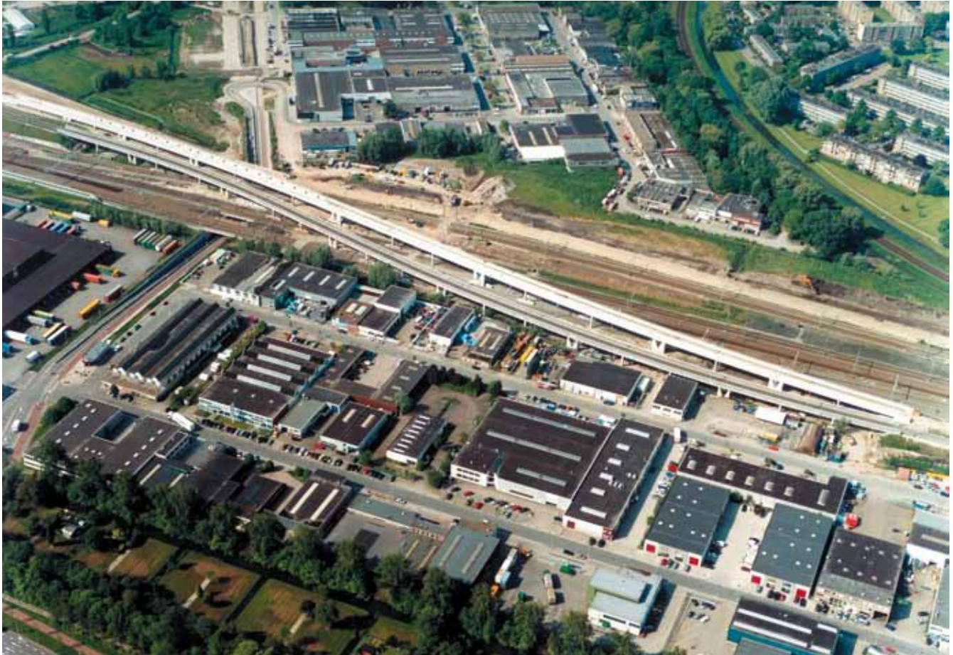
1. Luchtfoto HSL Fly-over
