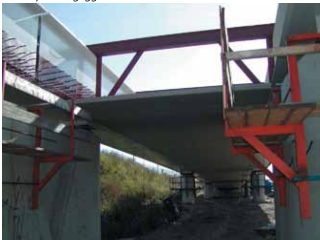
5. Hulpconstructie en prefab platen.
