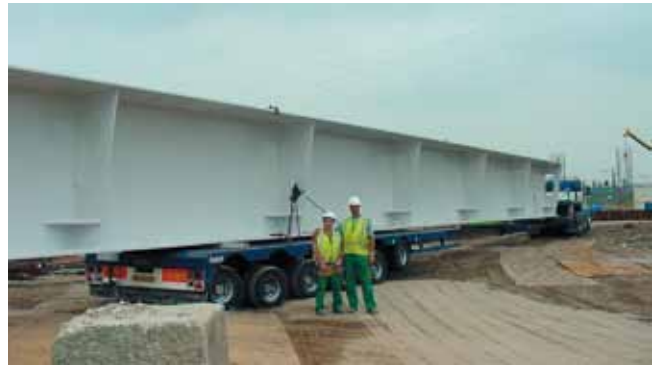
2. Transport brugsectie naar de bouwplaats.
