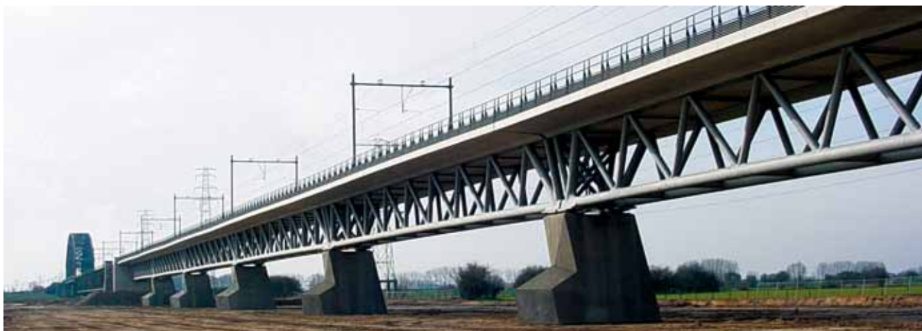
Aanzicht van de nieuwe aanbruggen.
