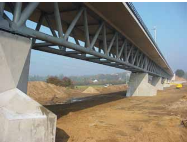
Afgemonteerde vakwerkbrug op de definitieve pijlers.
