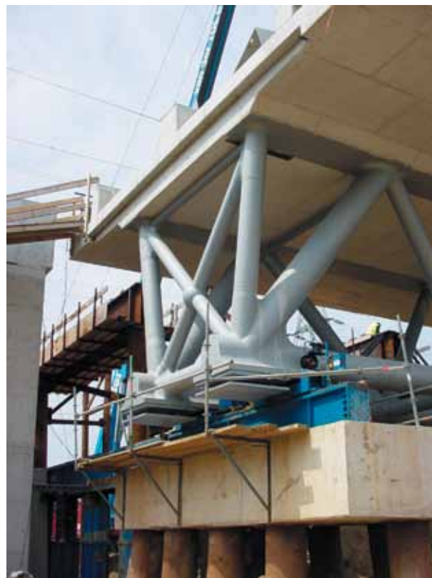
Einde vakwerklijger met zwaardere diagonalen.
