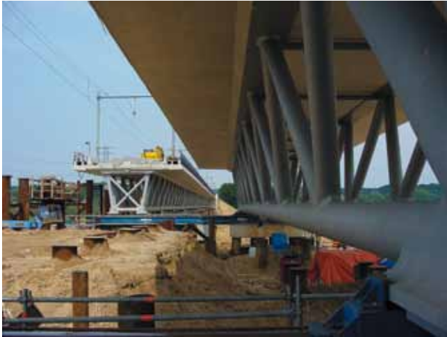
Montage van nieuwe bruggen naast de bestaande spoorbaan.
