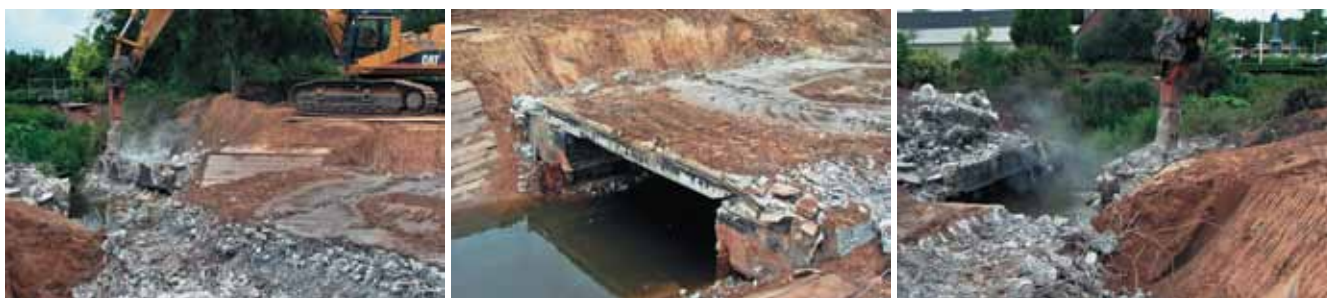
1. Sloop van de bestaande brug
