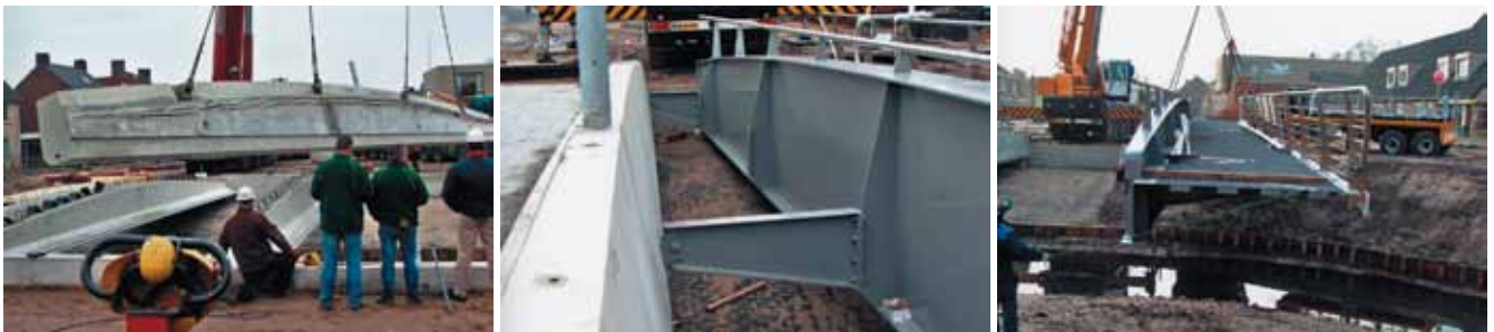
4. Montage van de brug
