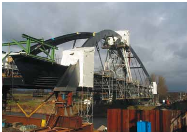
De bogen worden afgelast in een beschermde omgeving.
