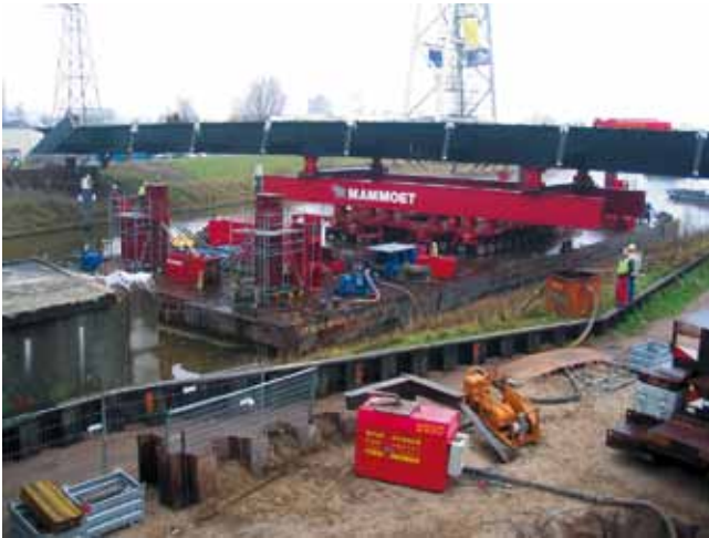
Landhoofd in aanbouw.
