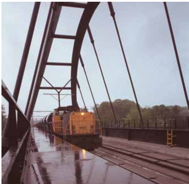
Brug met werktrein Railpro. (Foto: Martin Uitvlugt)
