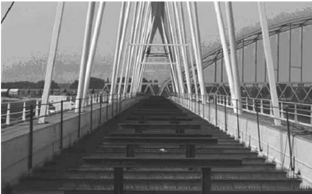
4. Onderste gedeelte rijvloer, bestaande uit stalen dwarsdraggers met betonnen breedplaten.
