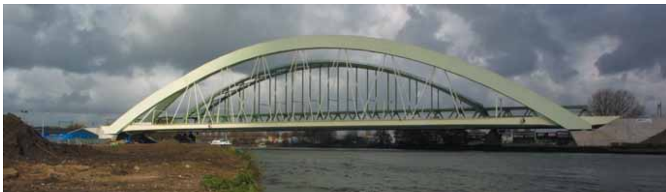
Werkspoorbrug te Utrecht op zijn definitieve plaats.
