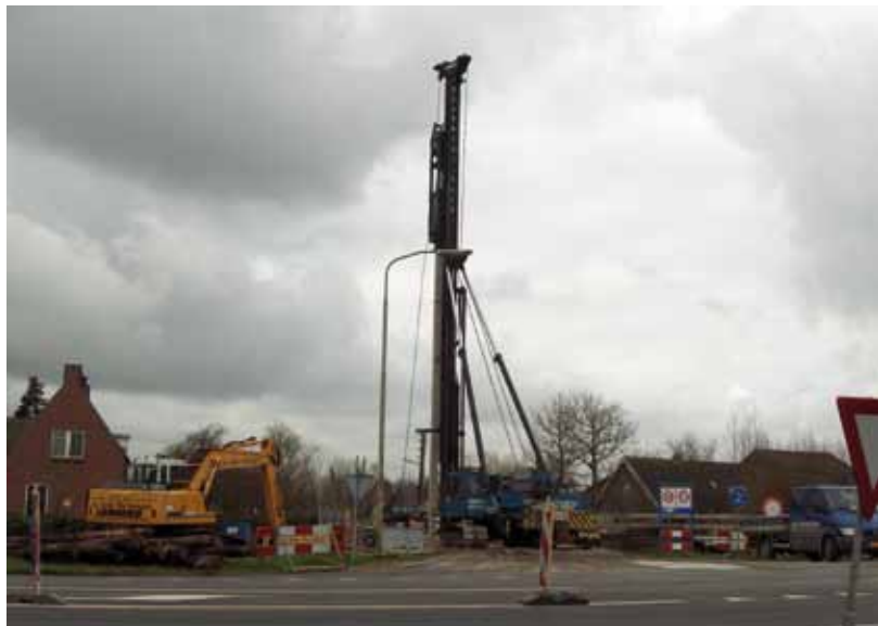
Inheien van de betonpalen. (foto: HHSK)
