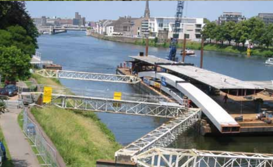
Linksonder: Aanvoer boogsectie Linksmidden: Samenstellen brugligger op pontons Linksonder: Aanvoer boogsectie
