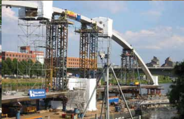
Rechtsboven: Brug op de werf Rechtsboven: Brugdek opgesteld op de pontons. Rechtsonder: Montage boog op de pontons
