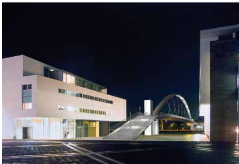
Boven: Een ranke boogconstructie zonder rivierpijlers Onder: Artist Impression van Bureau d' tudes Greisch
