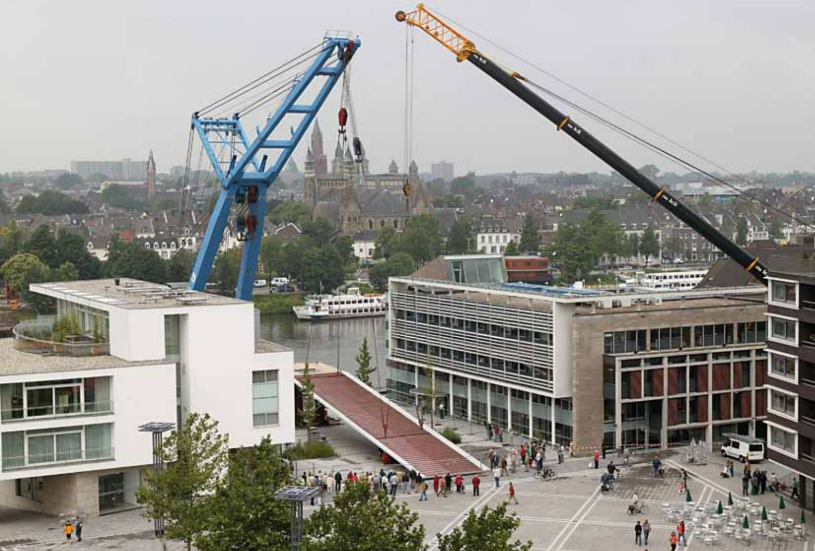
Het inhangen van de aanbrug op het Plein 1992
