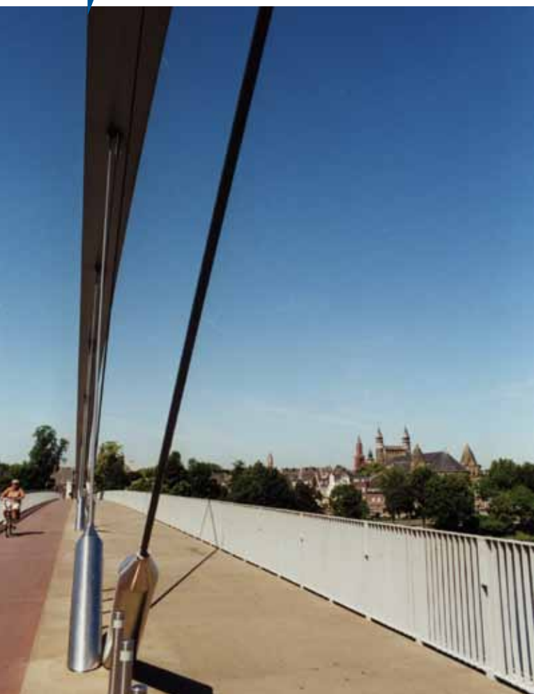
De verankering van de tuikabels in het brugdek.
