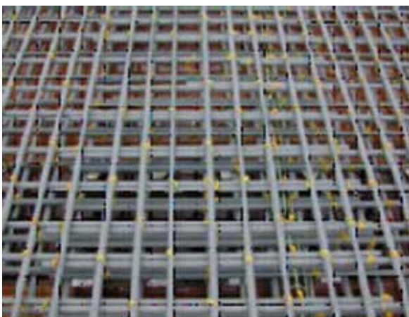
1. Voorbeeld van wapening rijvloer uitgevoerd in VVK.
