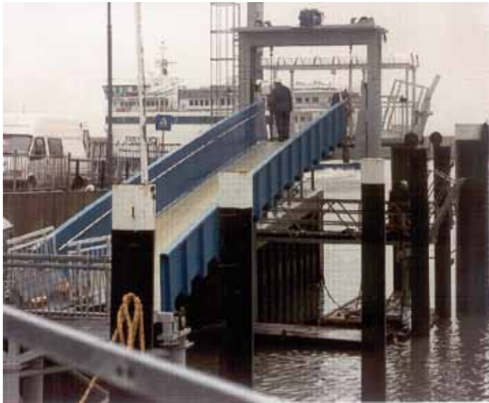
6. Brug in gerede toestand.
