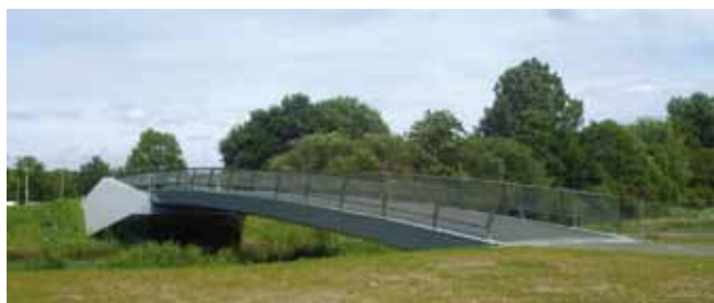
11. Dommelbrug, Eindhoven [www.polyproducts.nl]
