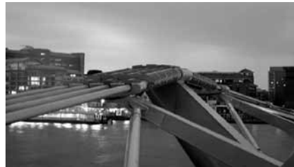
Afb. 15. Bevestiging van de kabels aan de pijlerconstructie.
