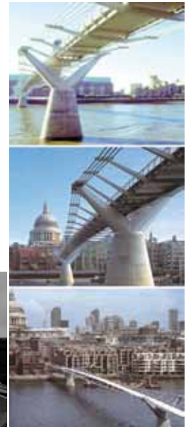
Afb. 14. De Londen Millennium bridge. De uitkragende liggers zitten om de circa 8 m.
