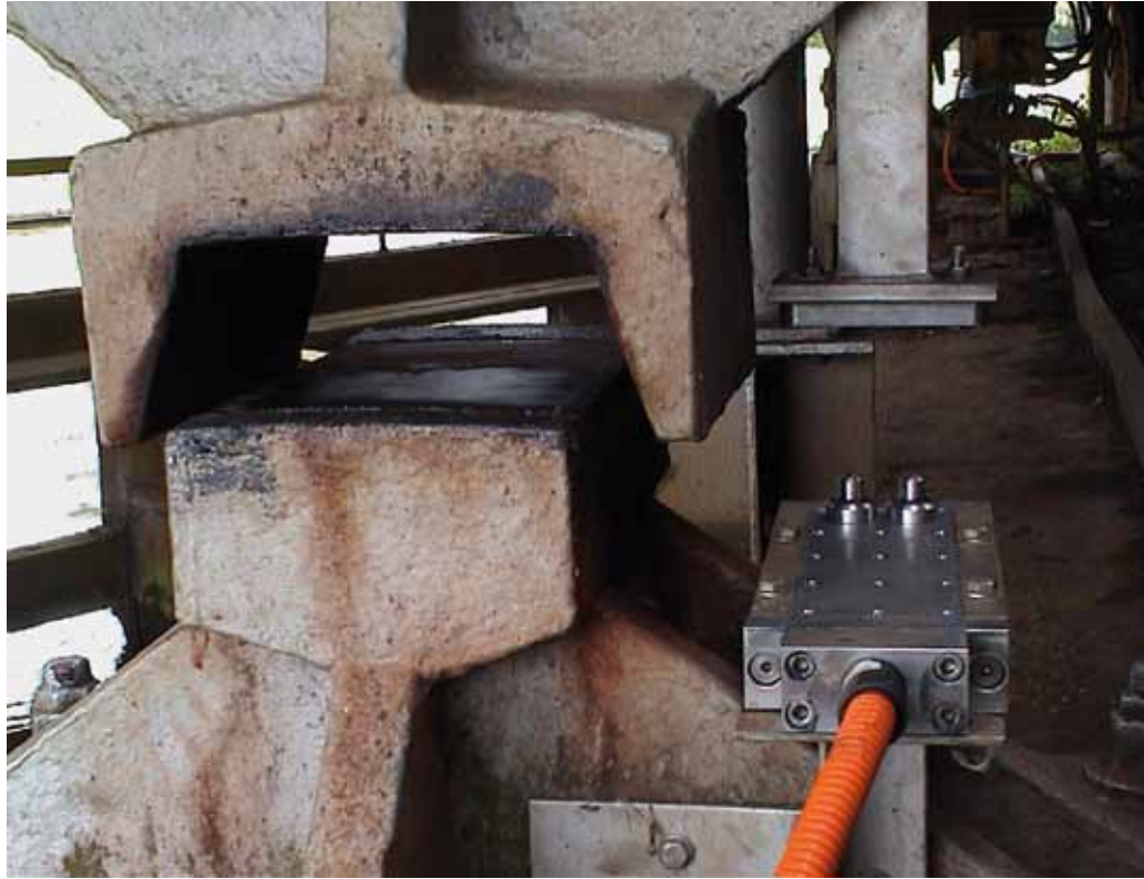
De juiste stand van de brug wordt gecontroleerd met glasvezelsensoren
