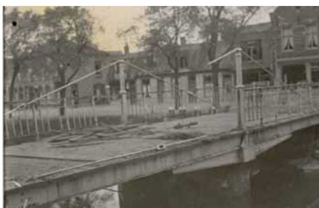
19. Schade aan de Keizersbrug na explosie zuurstoffles. (zowel links als rechts)
