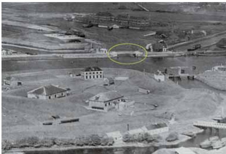
7. In de gele cirkel de dubbele basculebrug. Luchtopname 1930
