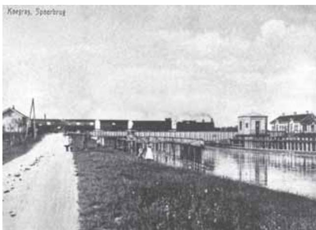
2. Spoorbrug over het Noord-Hollandskanaal, Opname 1900
