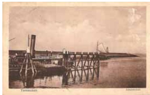
De ponton met de rij meerpalen in 1918. Hier kunnen we ook goed de drijfkist zien die in 1916 werd aangebracht tussen de dukdalven.
