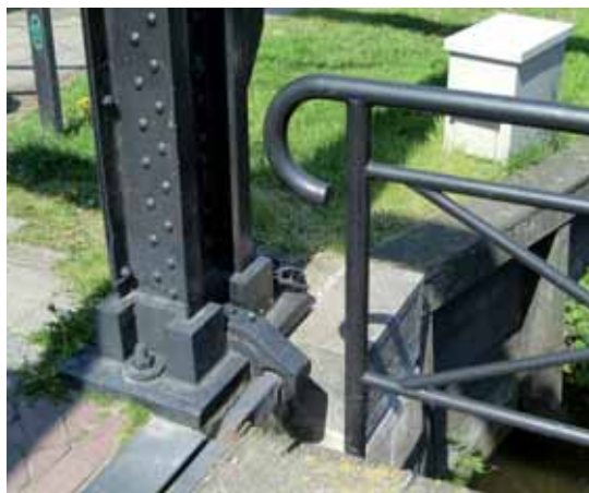
De Laatste Stuverbrug, detail voet hameistijl met draaipunt val
