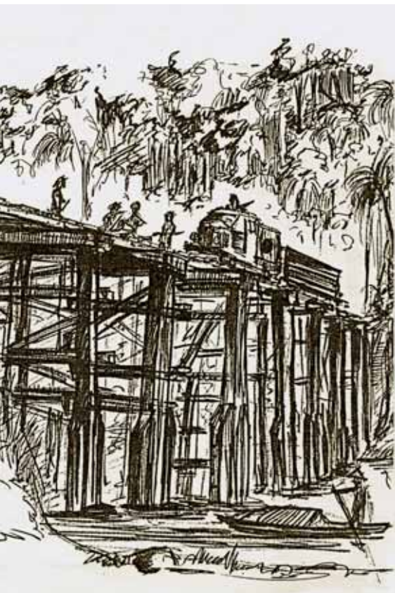
Een vrachtwagen op treinwielen voert rails voor de spoorbaan aan via een door krijgsgevangenen aangelegde houten brug.
