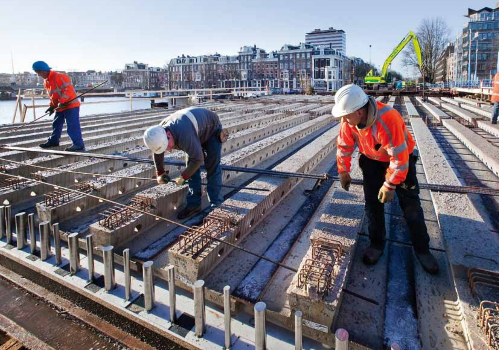
Liggers waarop het brugdek zal worden gestort
