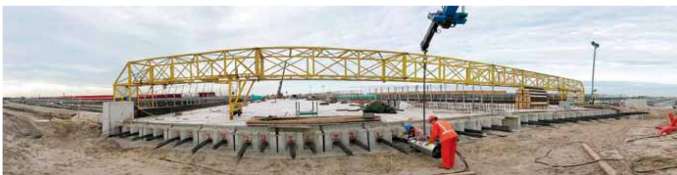
Het 3P systeem bij viaduct Lage Weide
