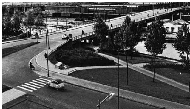
Viaduct Rozenlaan Rotterdam
