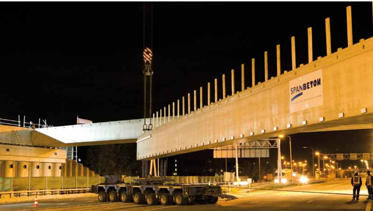
Montage in nachtelijke uren geeft weinig verkeershinder
