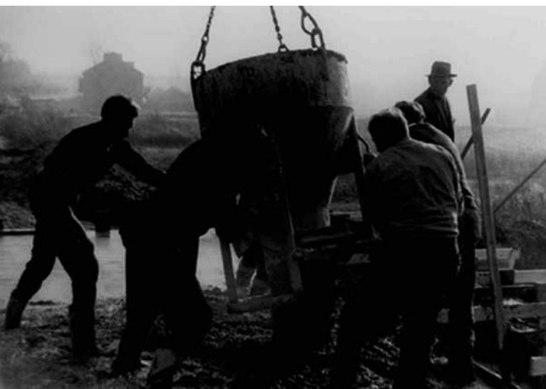
Foto uit 1963, Bouw betonbrug, Zijlwatering Wassenaar. personen van links naar rechts: Willem Knijnenburg, gebr. Overdevest, Jan Piet Haasnoot en Gijs Haasnoot.
