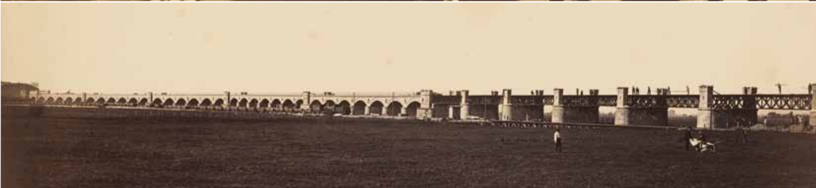
Vergezicht van de in aanbouw zijnde aanbruggen en viaduct over de uiterwaarden van de Rijn (TU Berlin Architekturmuseum)
