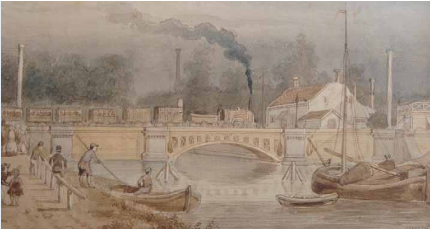
Draaibrug over de Haagvliet bij Den Haag
