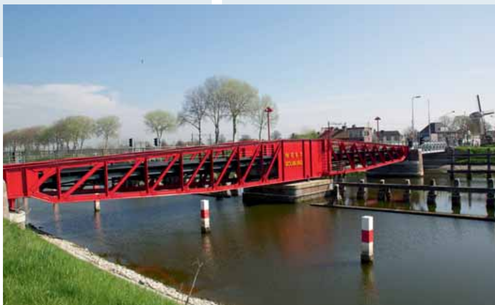
5 de gerenoveerde brug gereed
