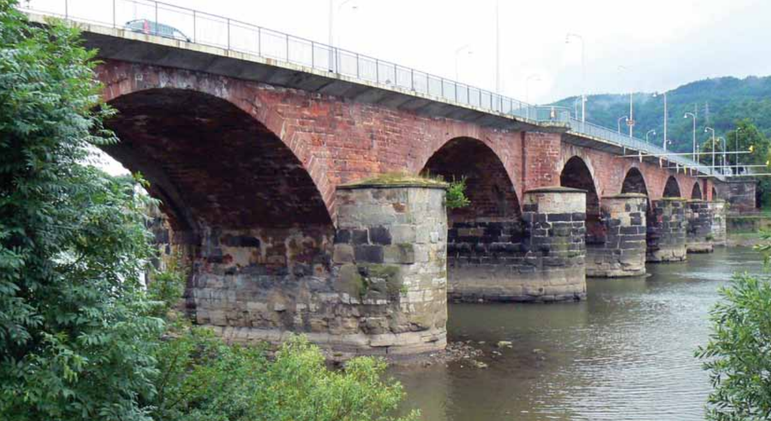
Romeinse brug over de Moezel te Trier met pijlers die nog uit de Romeinse tijd stammen. bron: www.strijdbewijs.nl
