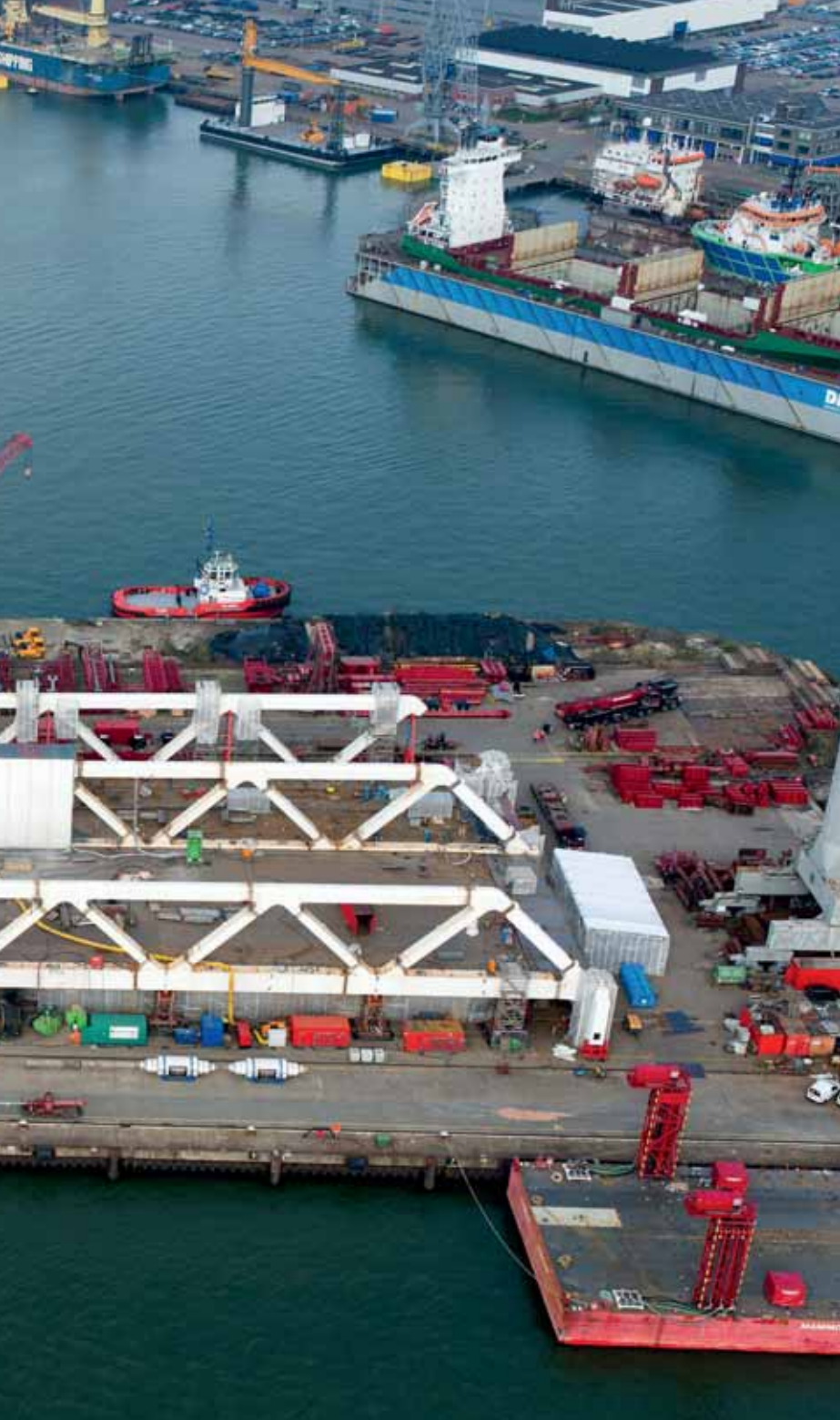
2 Stalen eindstuk contragewicht met trekstangen
