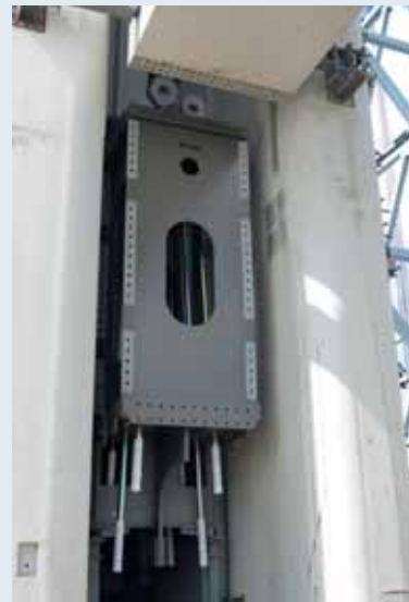
2 Stalen eindstuk contragewicht met trekstangen
