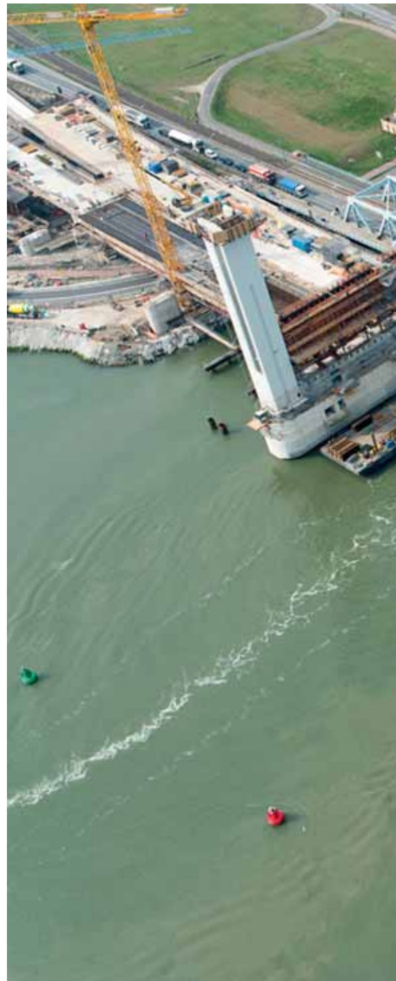
1 Botlekbrug in aanbouw; één contragewicht in uitvoering tussen de linker pijlers
