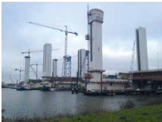
9 De betonnen pijlers
