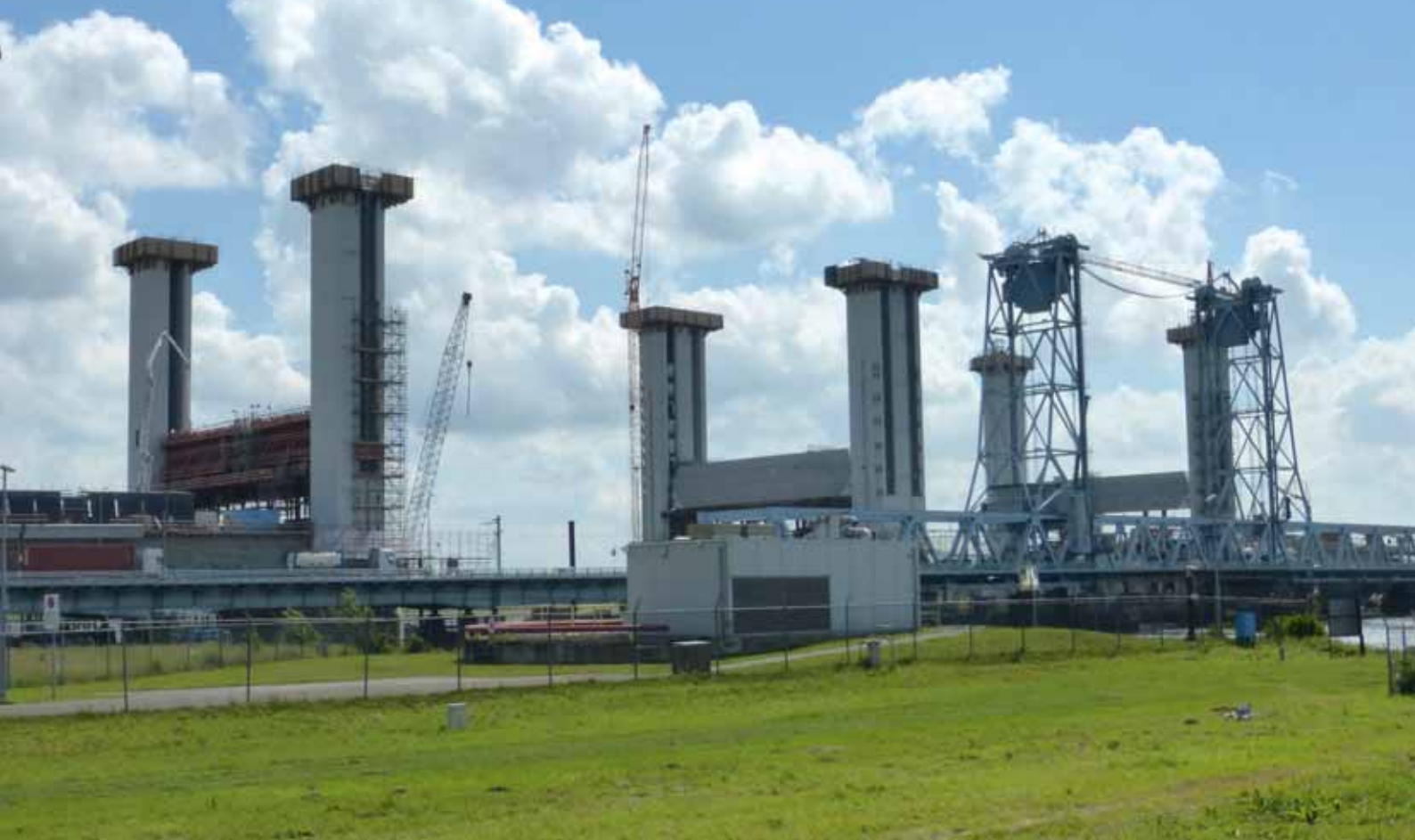
De betonnen pijlers met één contragewicht in aanbouw
