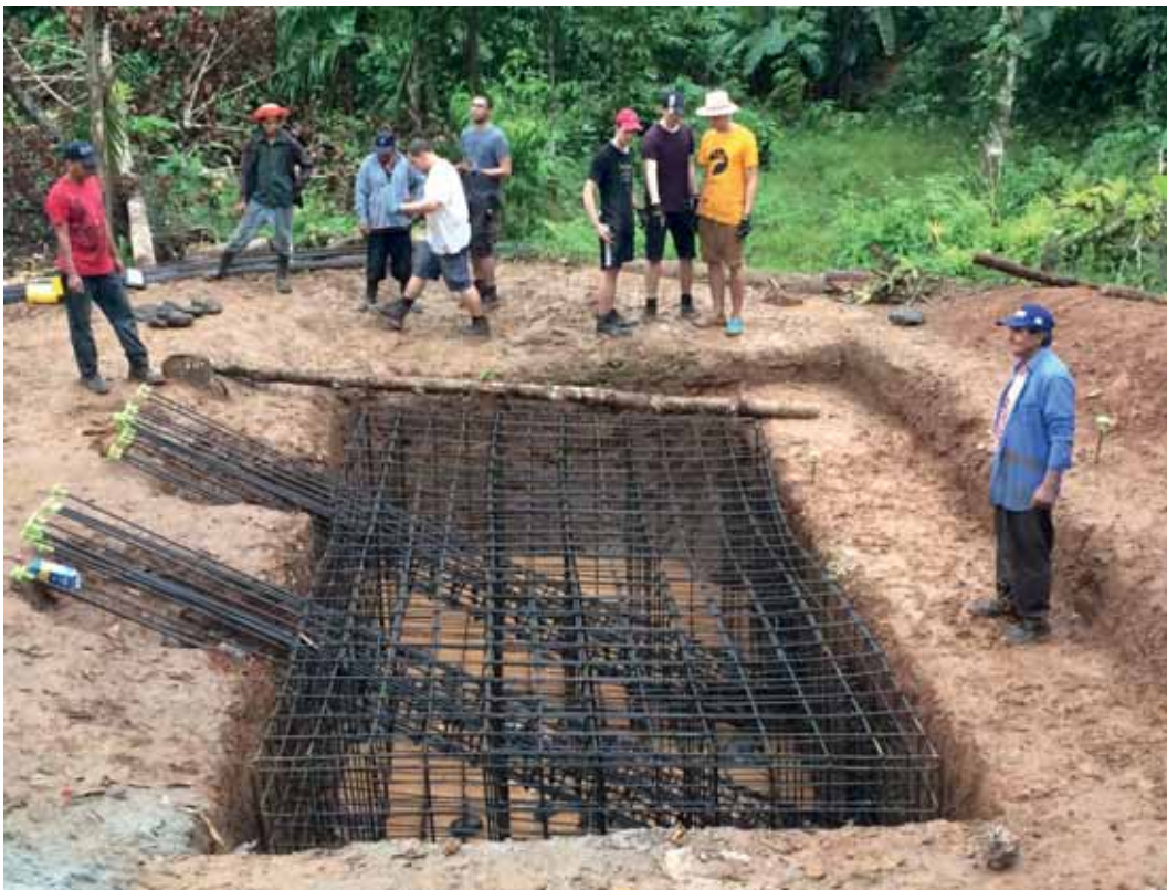
↑ wapening in voldoende droog ankerbloksparing
