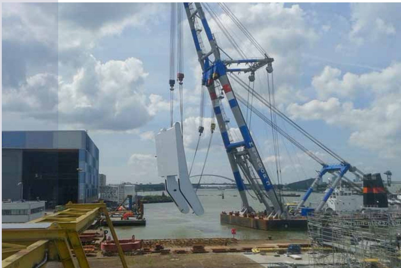
Plaatsen val op ponton
