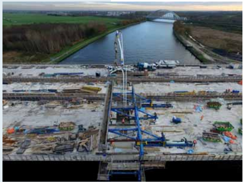
↑ Stort van het sluitstuk van de nieuwe brug.
