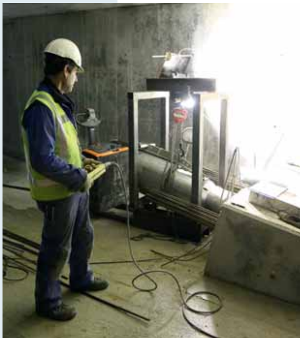
← 11 Aanbrengen continuïteitsvoorspanning in de koker.
