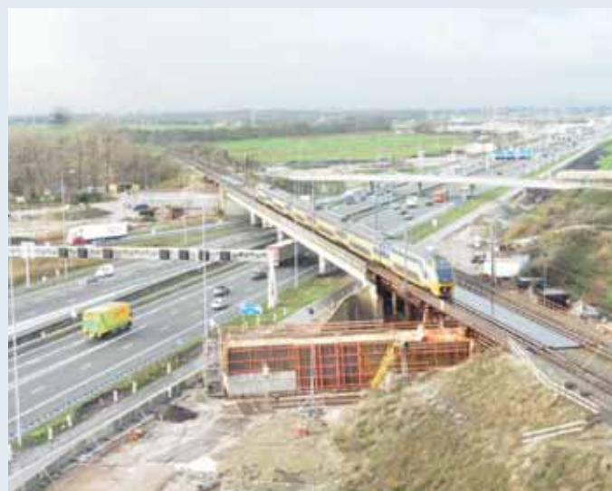
↑ Bouw van de tijdelijke landhoofden
