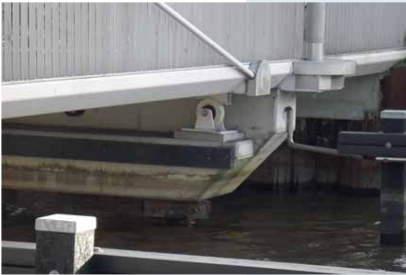
↑ Oplooptiel ter plaatse van landhoofd met olopblok
