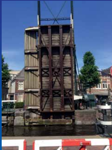
Geopende brug aan Rijnlandse zijde Extra voetbrug aangebracht
