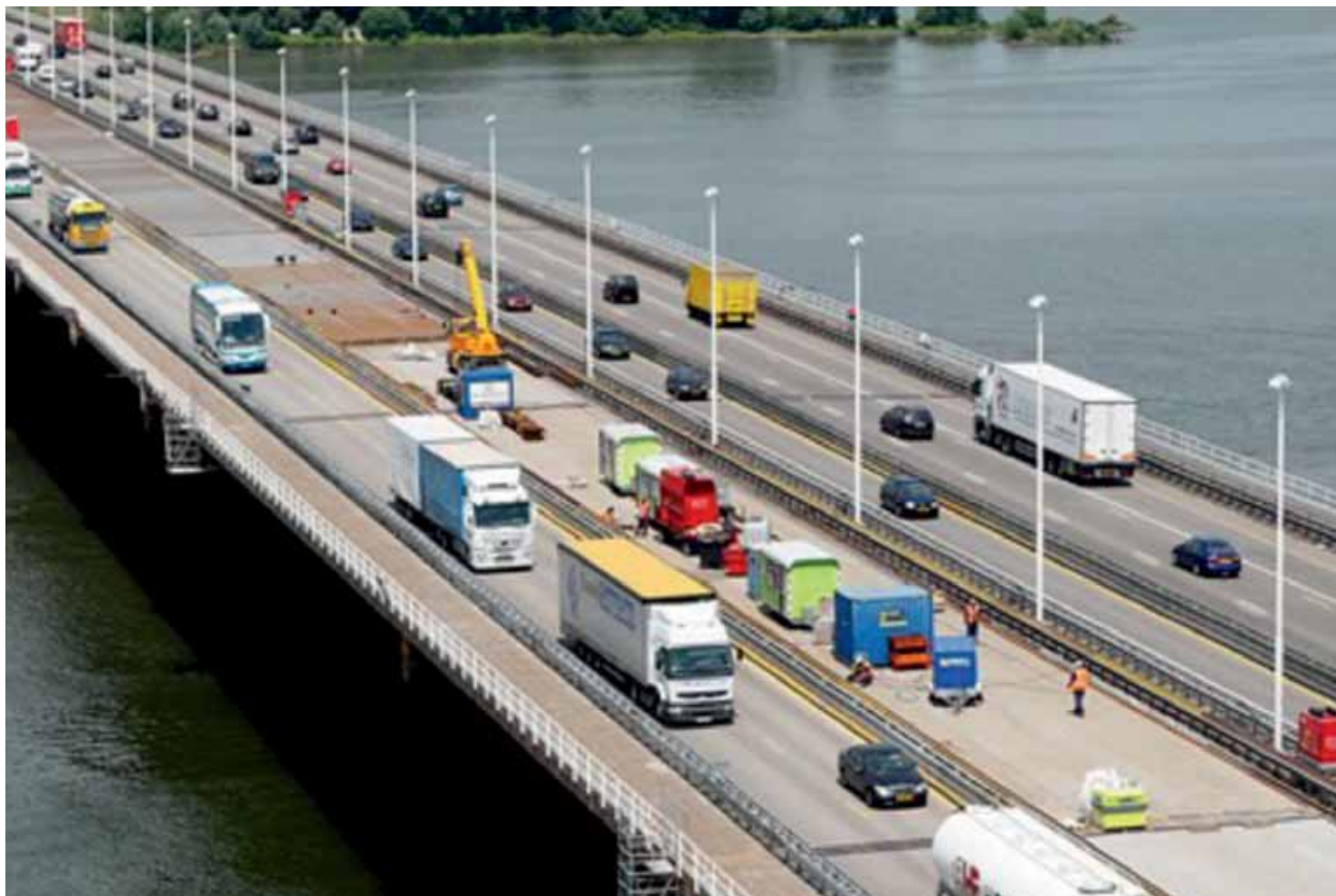
7 HSB-overlaging Moerdijkbrug. © Aerial
