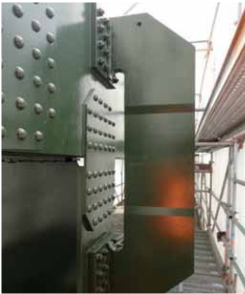
14 Bypass krachtsoverdracht van hanger naar boog in de brug bij Beek. © Arup
