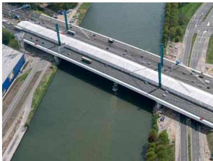
17 Galecopperbrug met tent voor overlagingwerkzaamheden – VSLiggers geplaatst. © Snowwhite
