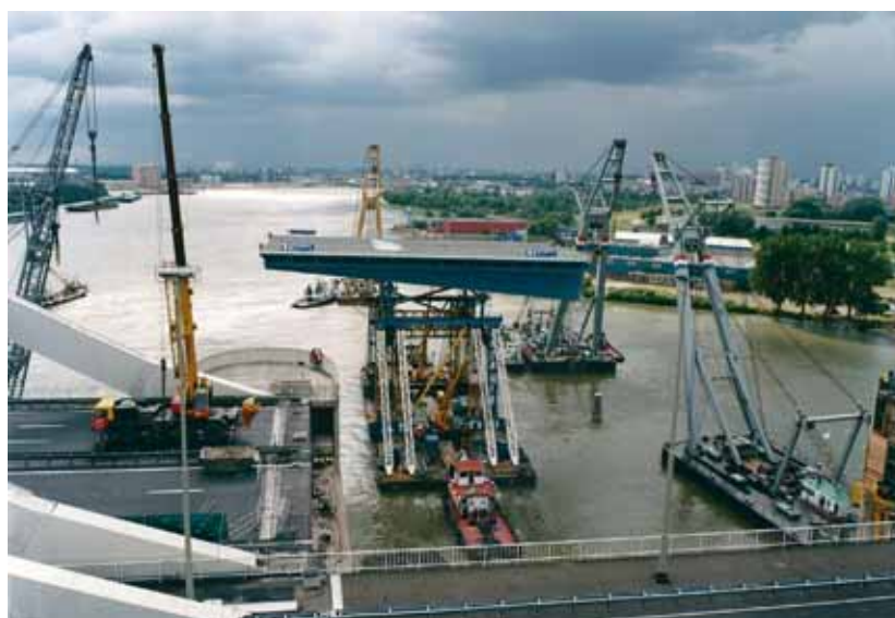
3 Vervanging klap Basculebrug 2e Van Brienenoordbrug in 1997. © Rijkswaterstaat
