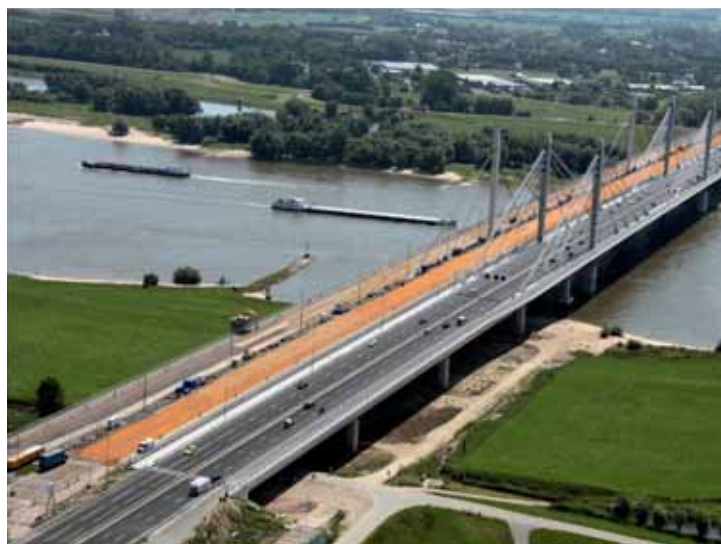
16 Tacitusbrug – links brug 1; rechts brug 2: betonnen koker tuibrug met 2x twee pylonen. © Thea van den Heuvel
