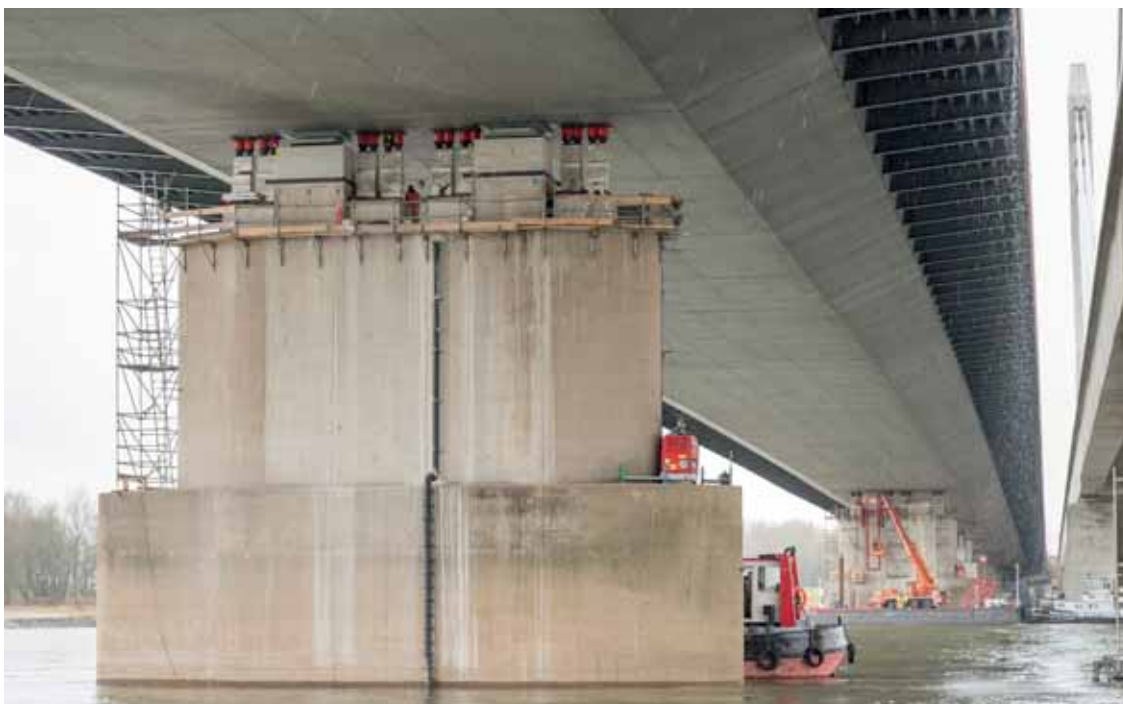
15b Tacitusbrug Ewijk - links onderzijde brug 1 rechts, nog net zichtbaar, brug 2 betonnen koker tuibrug
