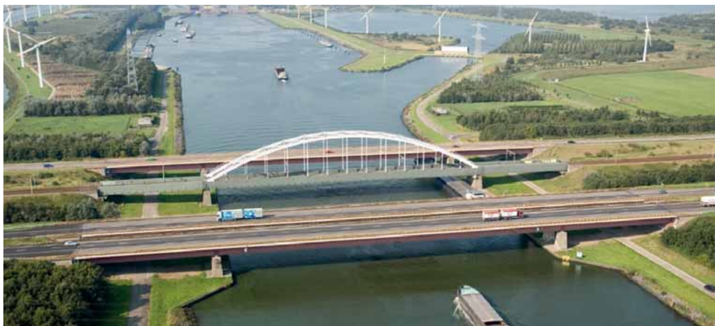
18 Stalen liggerbrug op de voorgrond over de Schelde-Rijnverbinding in de A58. © Aerial
