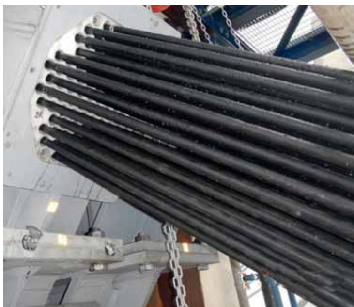
23 Nieuwe tuien t.p.v. zadelconstructie in pylloon van brug 1- Tacitusbrug Ewijk
