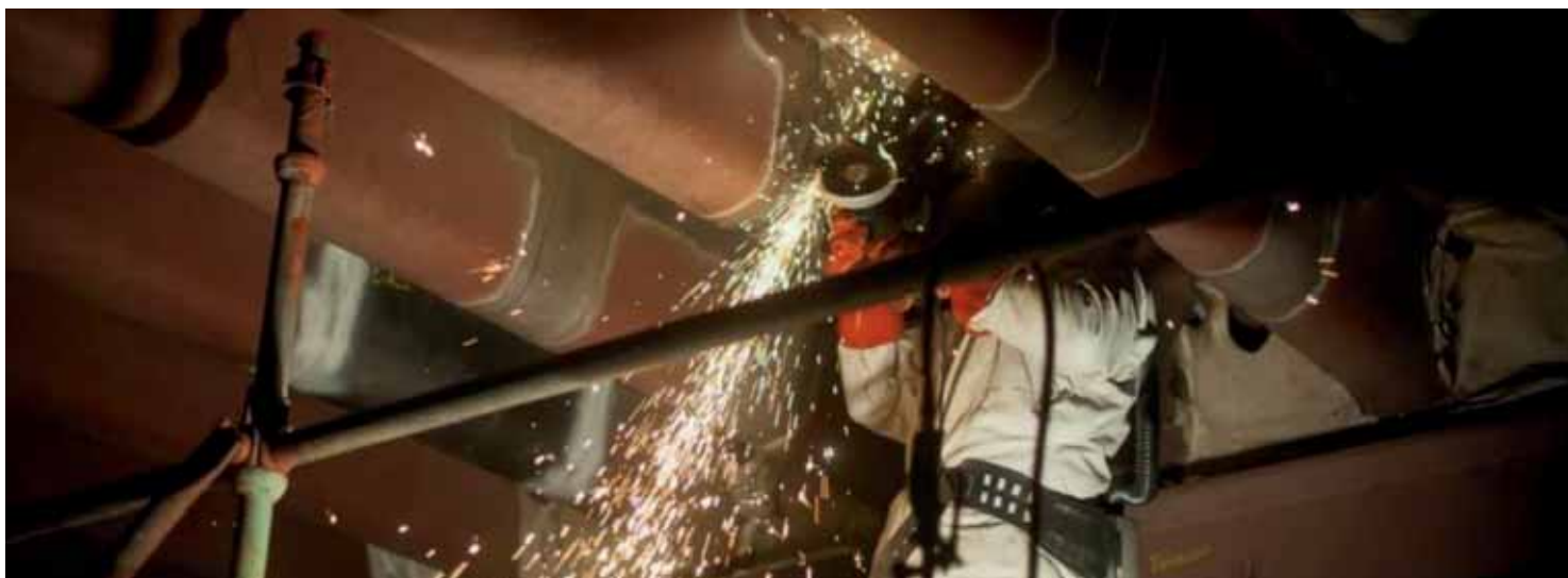
20a+b Lassen vermoeiingsscheuren Galecopperbrug onder geconditioneerde omstandigheden
