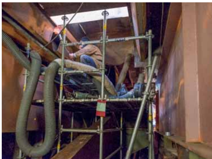
20a+b Lassen vermoeiingsscheuren Galecopperbrug onder geconditioneerde omstandigheden
