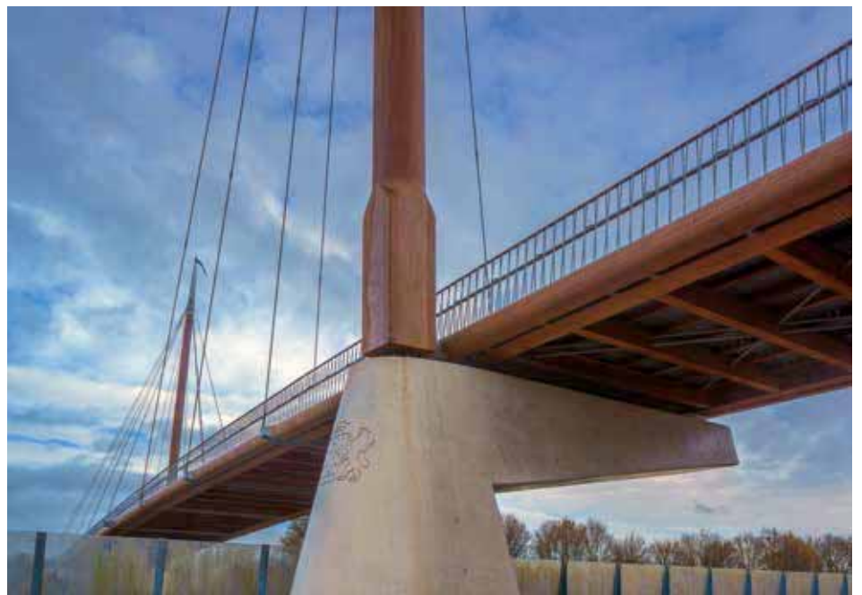
'Sluisdeur als brugdek'
