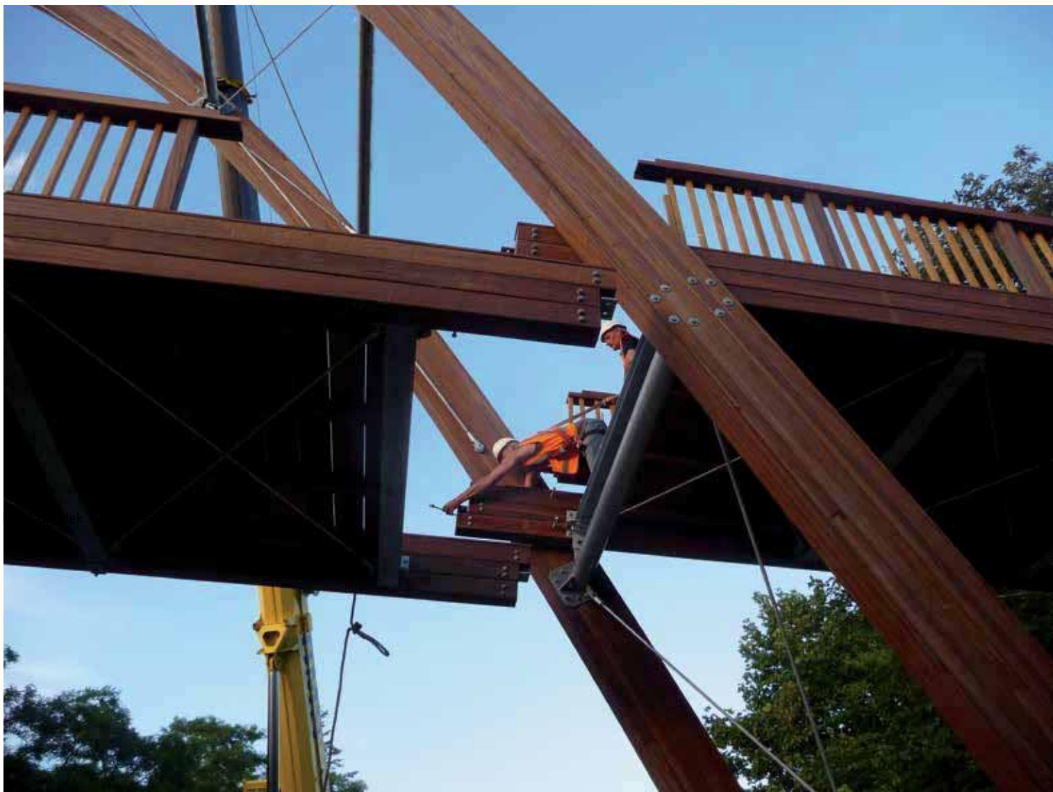
Montage Boogbrug Frederikssund (DK)
