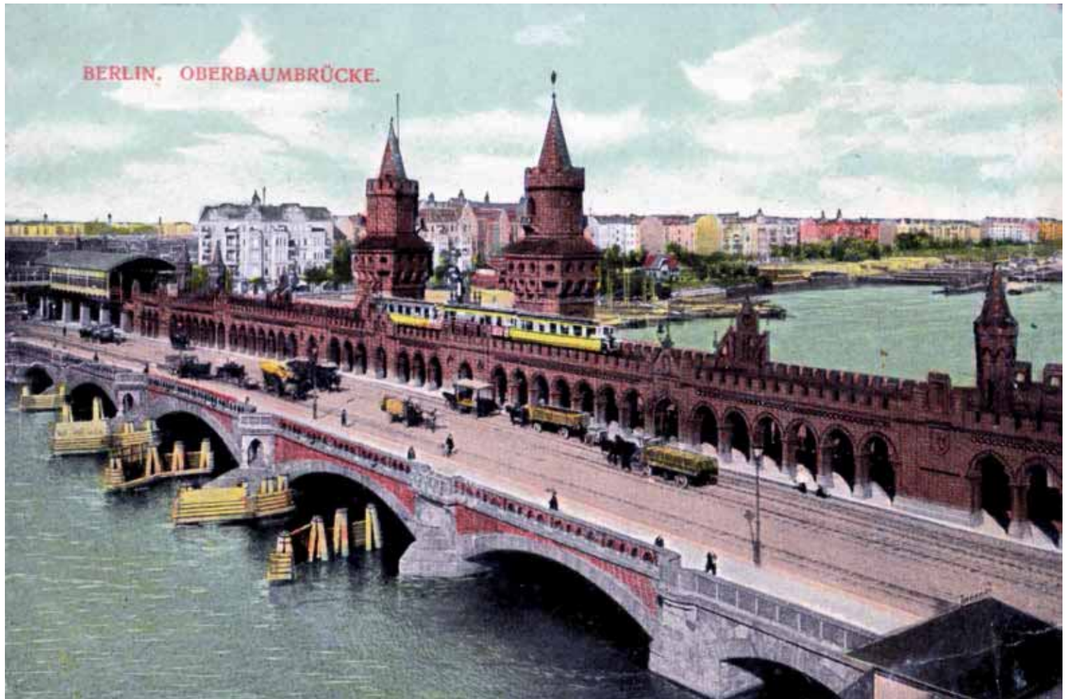
Oberbaumbrücke met U-Bahn en paard-en-wagens, ingekleurde foto begin 20e eeuw, NW-zijde. Links het metrostation Stralauer Tor.
