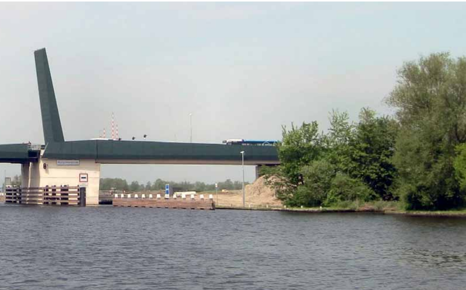
↑↓ 6 Scheve zuil op kelderdek (© Projectbureau De Centrale As)
