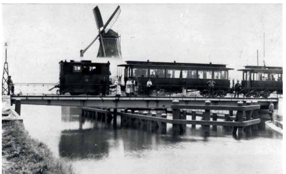
2 De draaibrug op de Oude Bergumerdam met een tram van de Nederlandsche Tramweg Maatschappij, omstreeks 1914. De tram rijdt op de lijn van Drachten naar Leeuwarden in de richting Leeuwarden. © Sumar.nl, D. Franke
