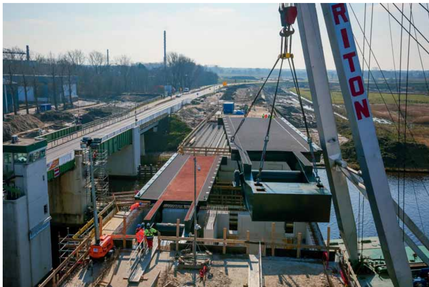
10 Montage beweegbare gedeelte (© Projectbureau De Centrale As)
