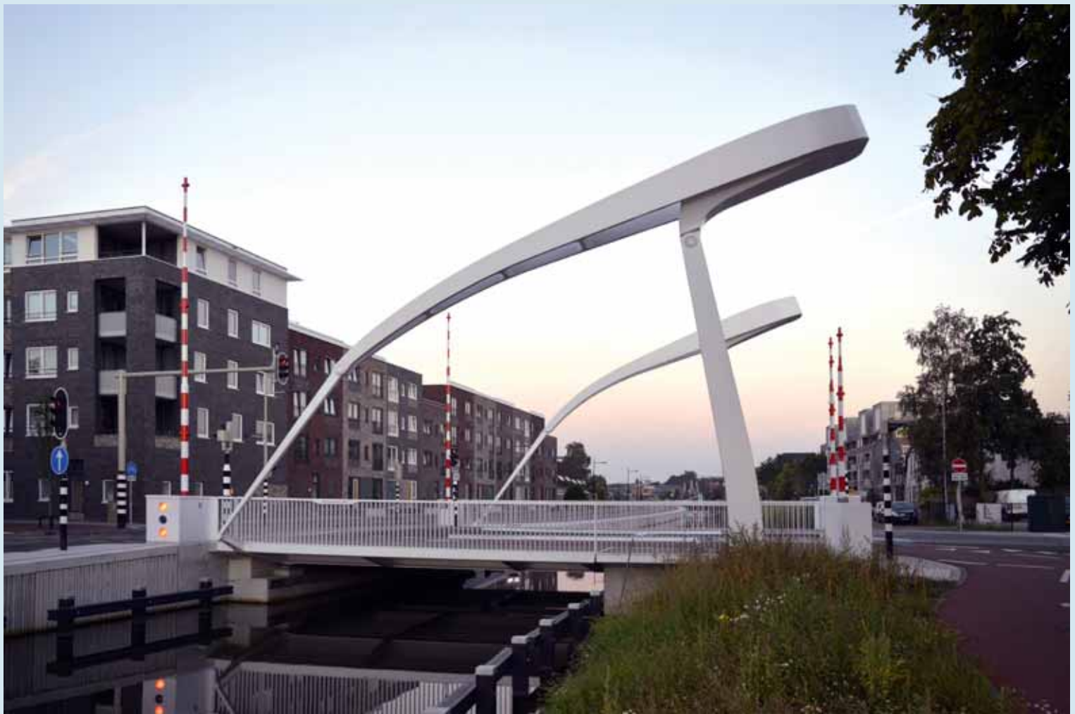
↑ ↓ Brug Groningerstraat na aanpassing openingshoek van 84° naar 75°
