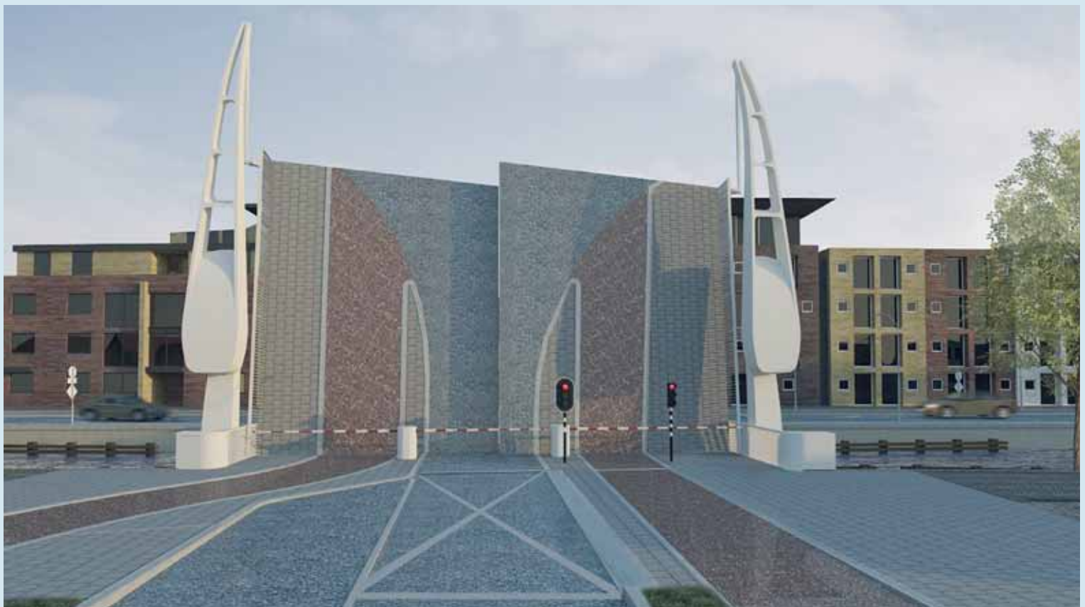
↑ ↓ Brug Groningerstraat na aanpassing openingshoek van 84° naar 75°
