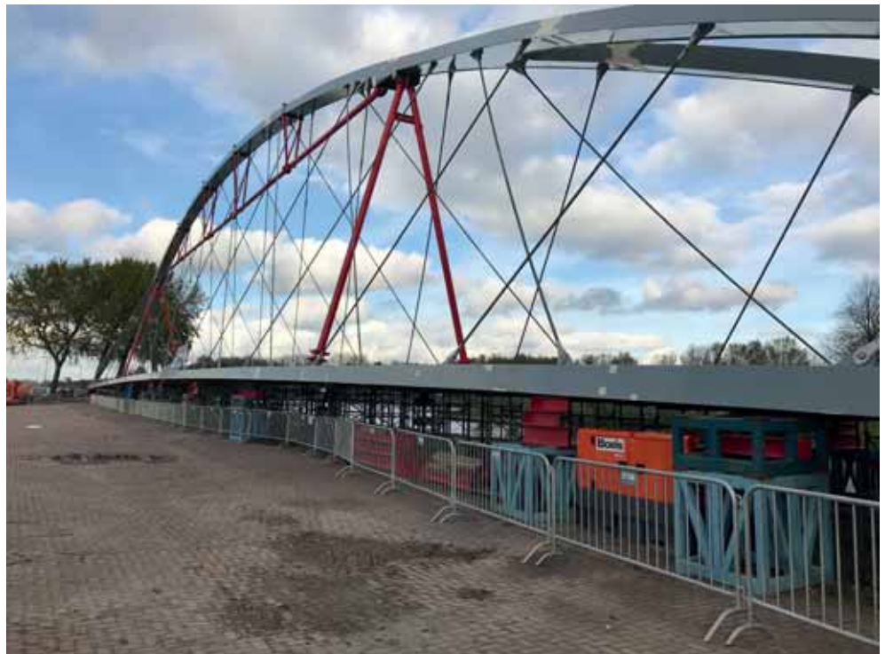
22 Tijdelijke versterking van de boogbrug met verticale bokken en horizontale trekband
