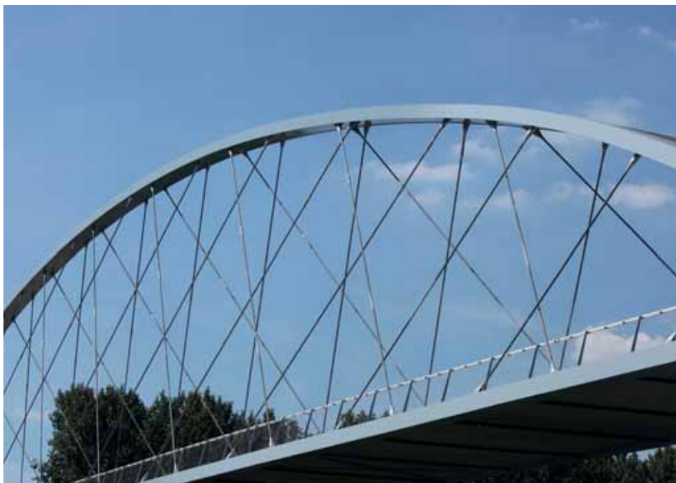
15 In totaal heeft de boogbrug 52 hangers.
