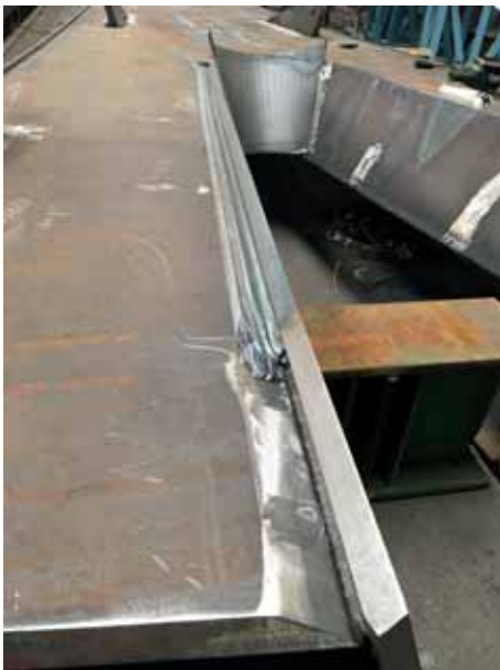
21 Productie van de staalconstructie
