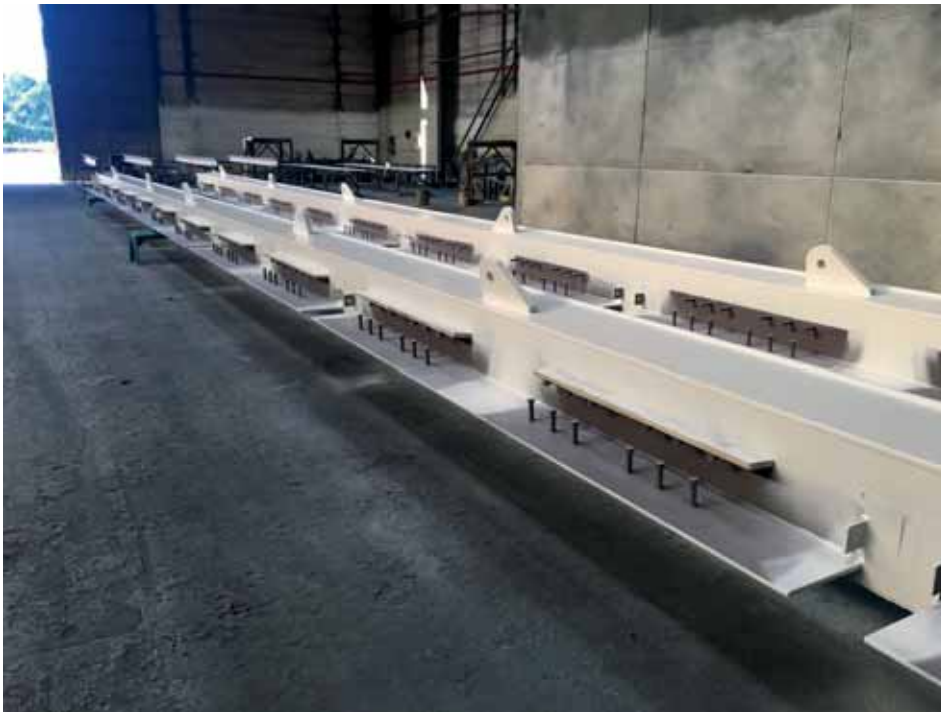
9 Randliggers met stiftdeuvels op werkplaats CSM
