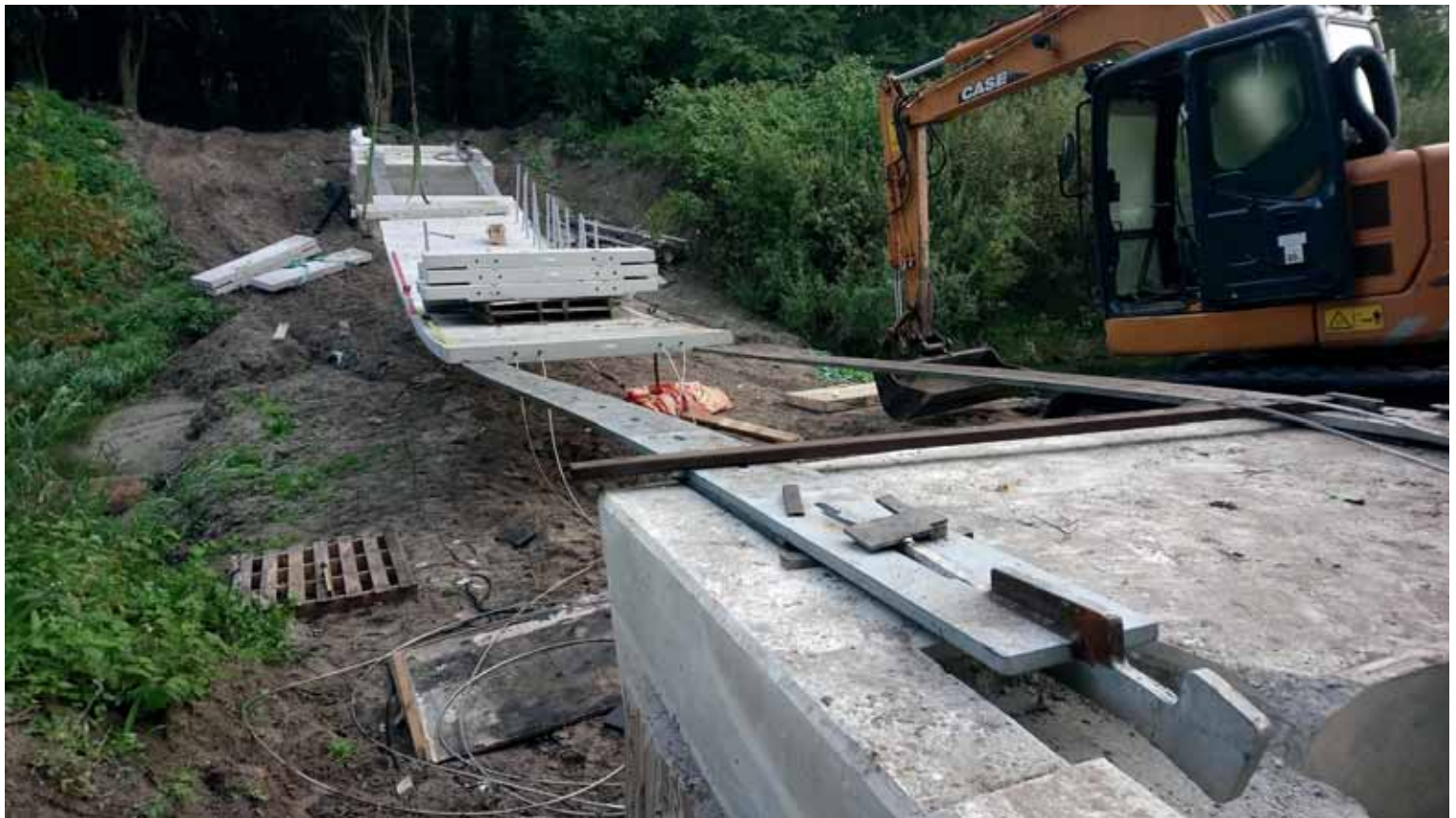
4 Aanbrengen brugdekplanken op de strippen
