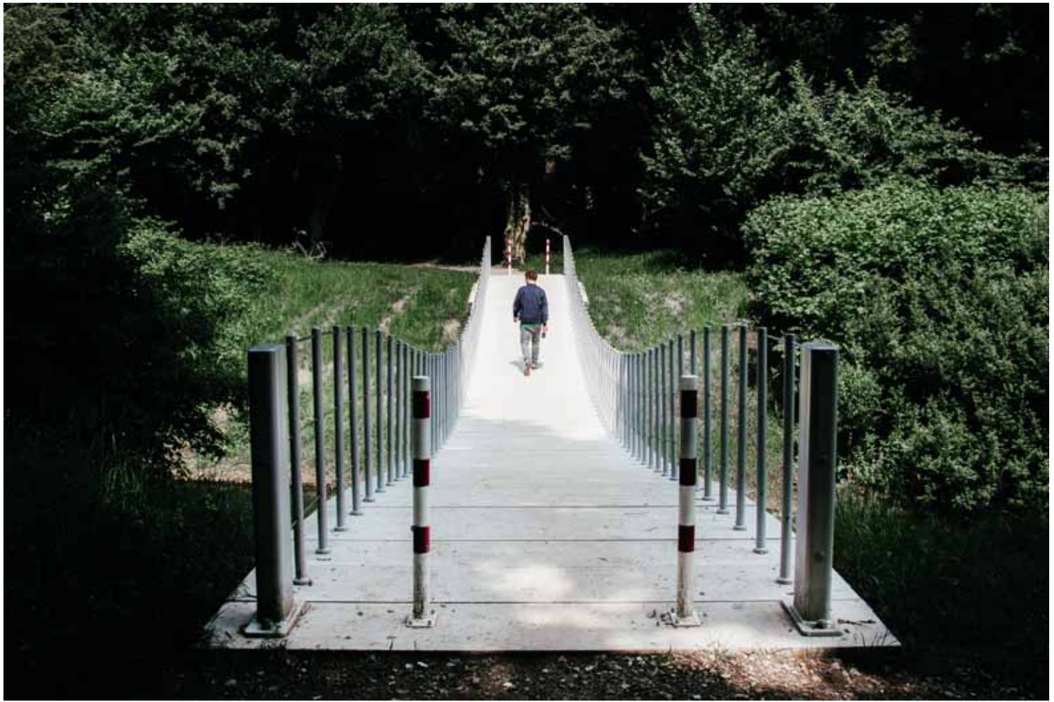
3 Toegang tot brug - eindbaluster
