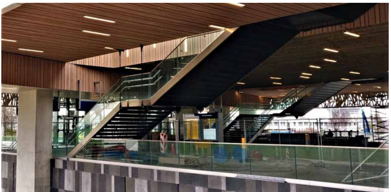
Aanzicht opgehangen trapconstructie
