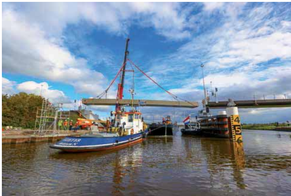
Inhijzen van de brug. Foto: Bouwfotografie.nl
