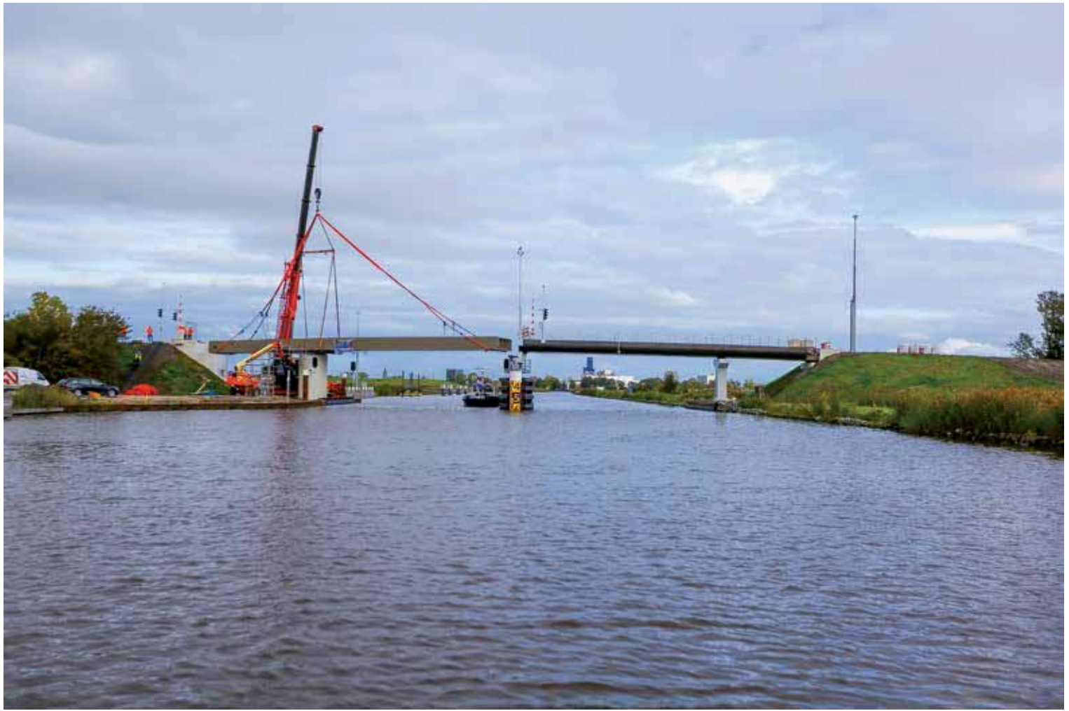
Brug over het Harinxmakanaal, nabij Ritsumasyt. Foto: Bouwfotografie.nl
