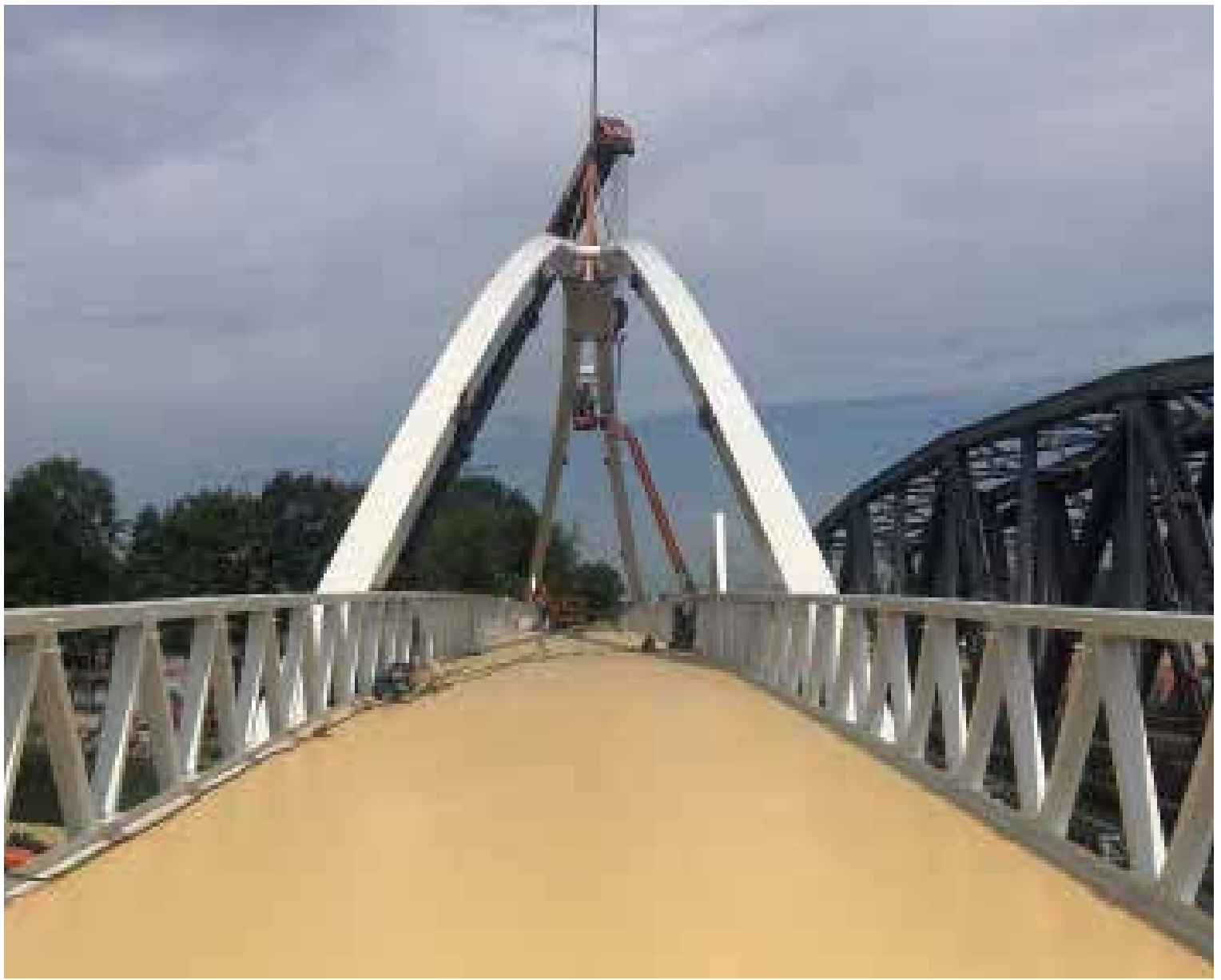
Aanvoer en montage boog
