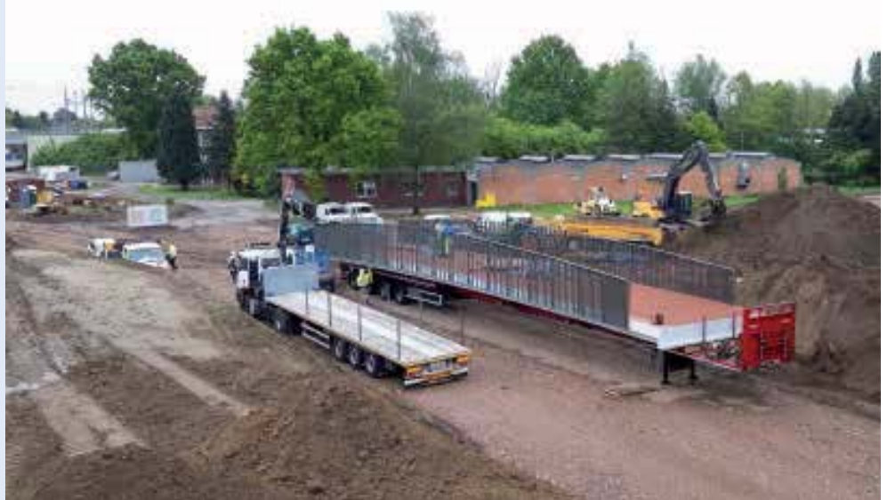
Inhijzen composietbrug in de F11
