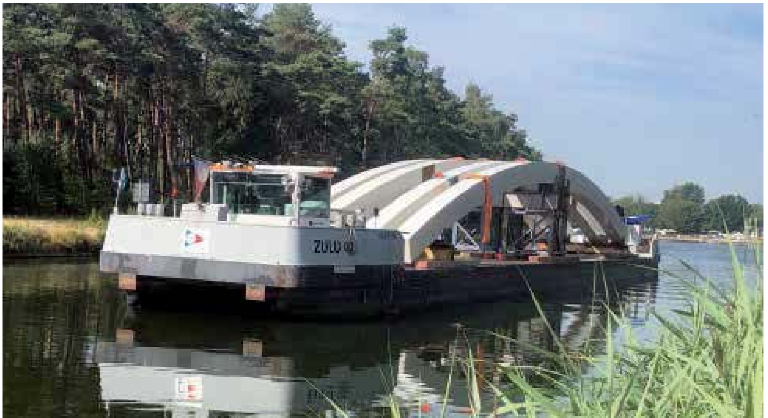
Aanvoer en montage boog
