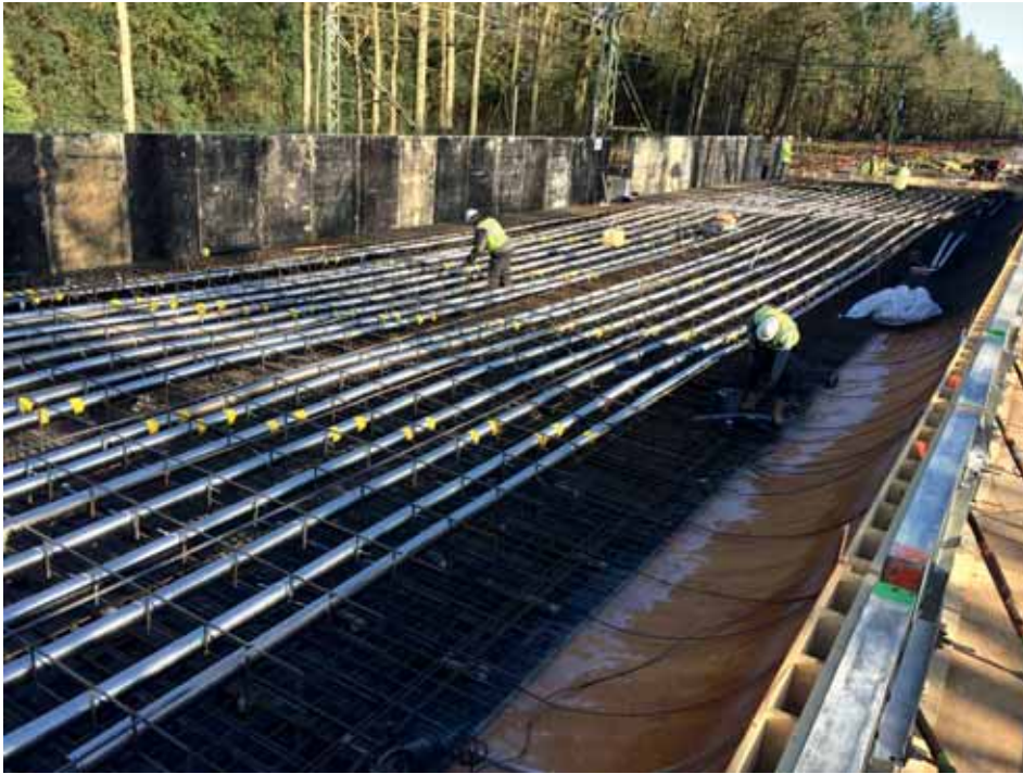
Aanbrengen voorspankabelomhullingen
