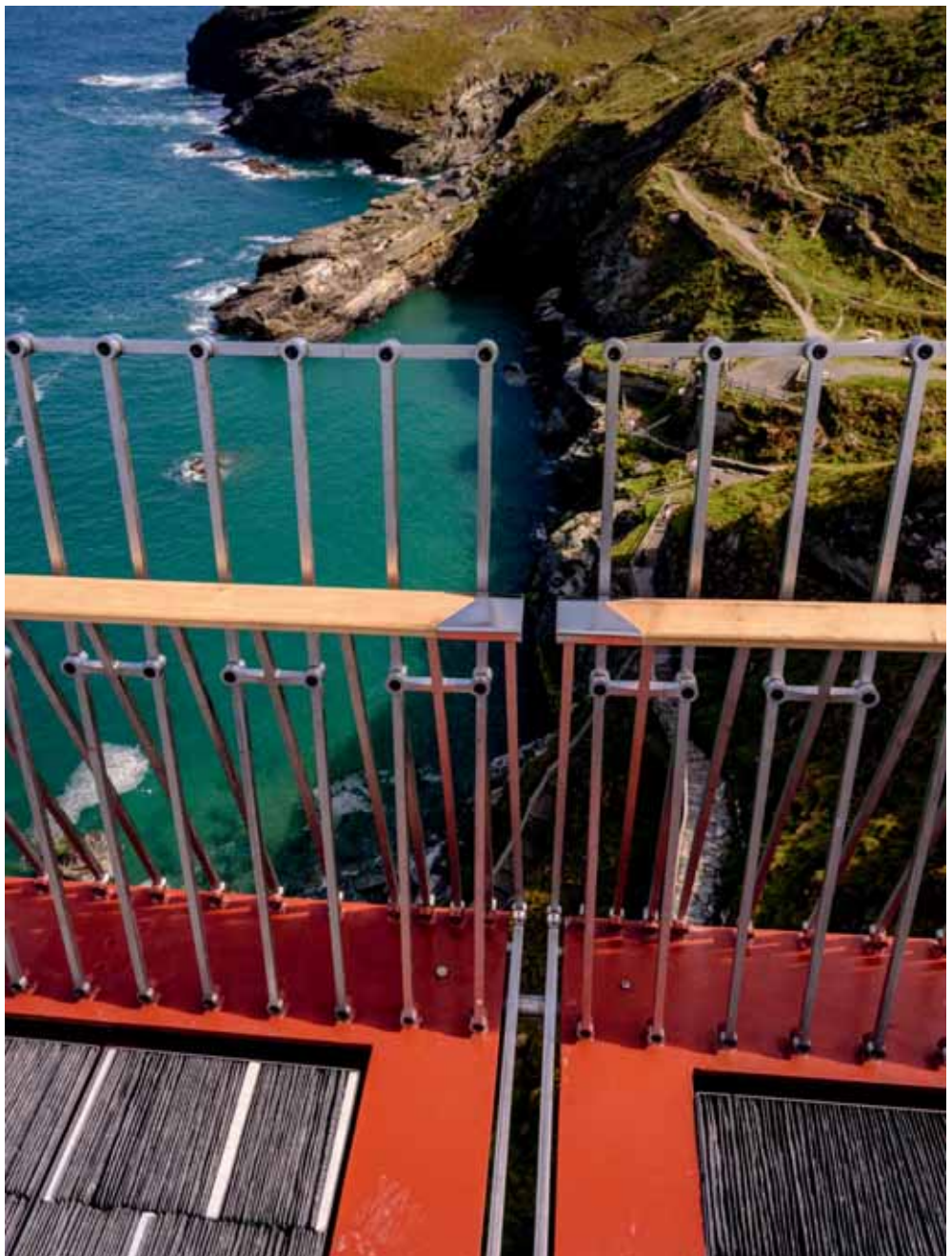
Opening tussen de twee brugdelen met deuveld
