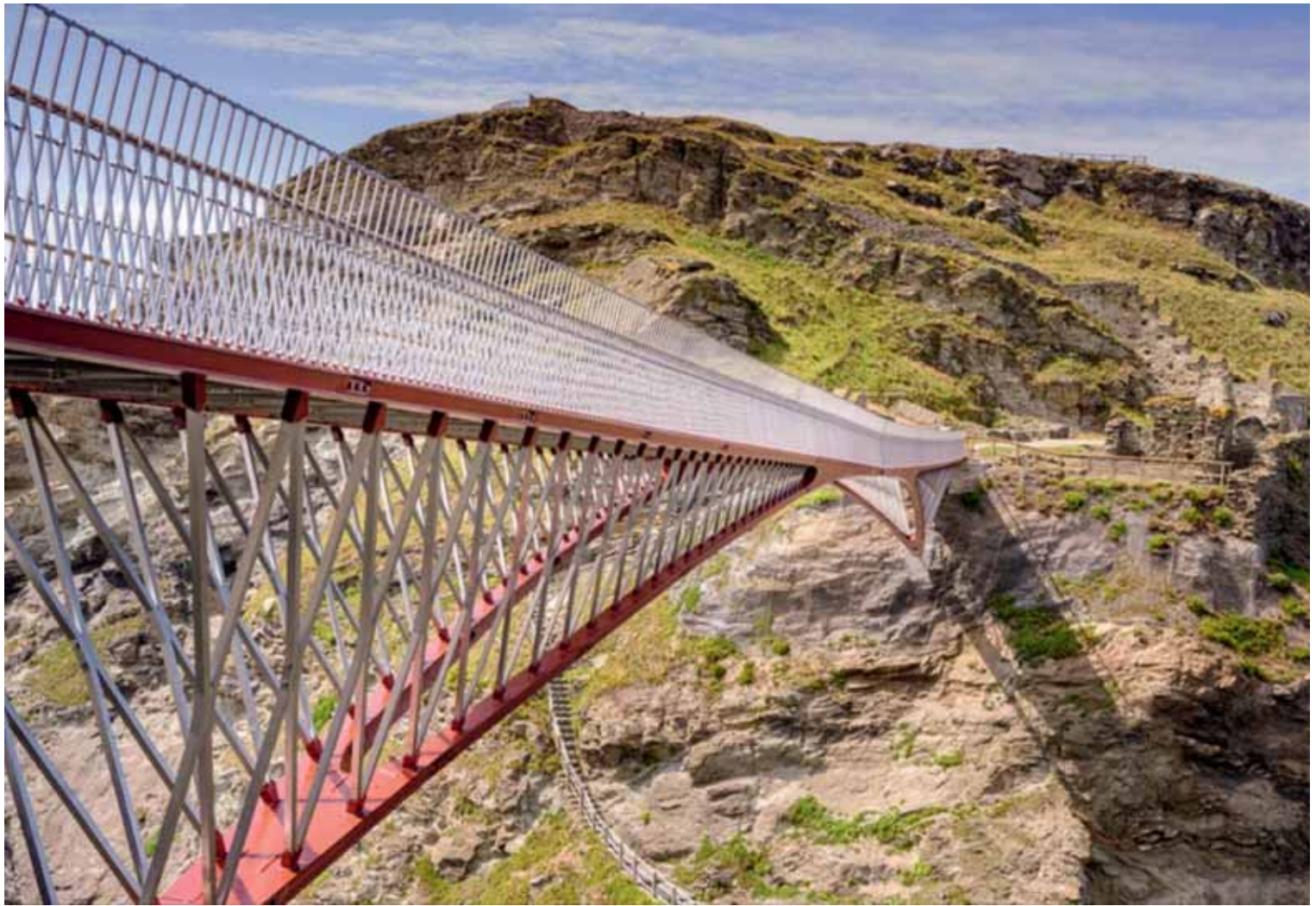
Zijaanzicht van de nieuwe brug.
