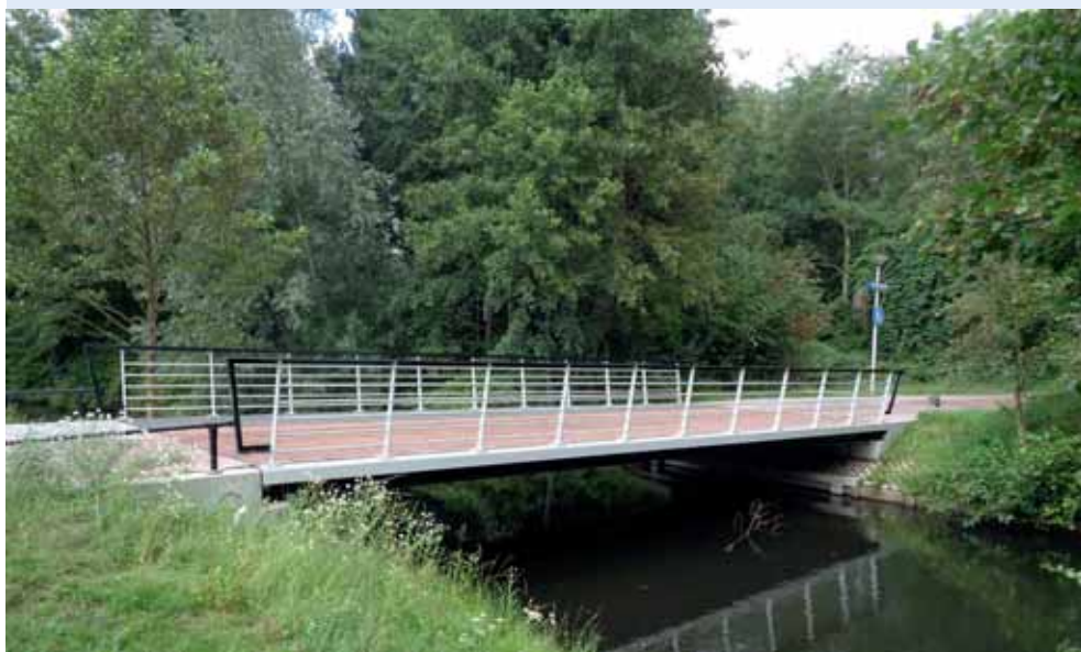
6 Brug in de wijk Rustenburg
