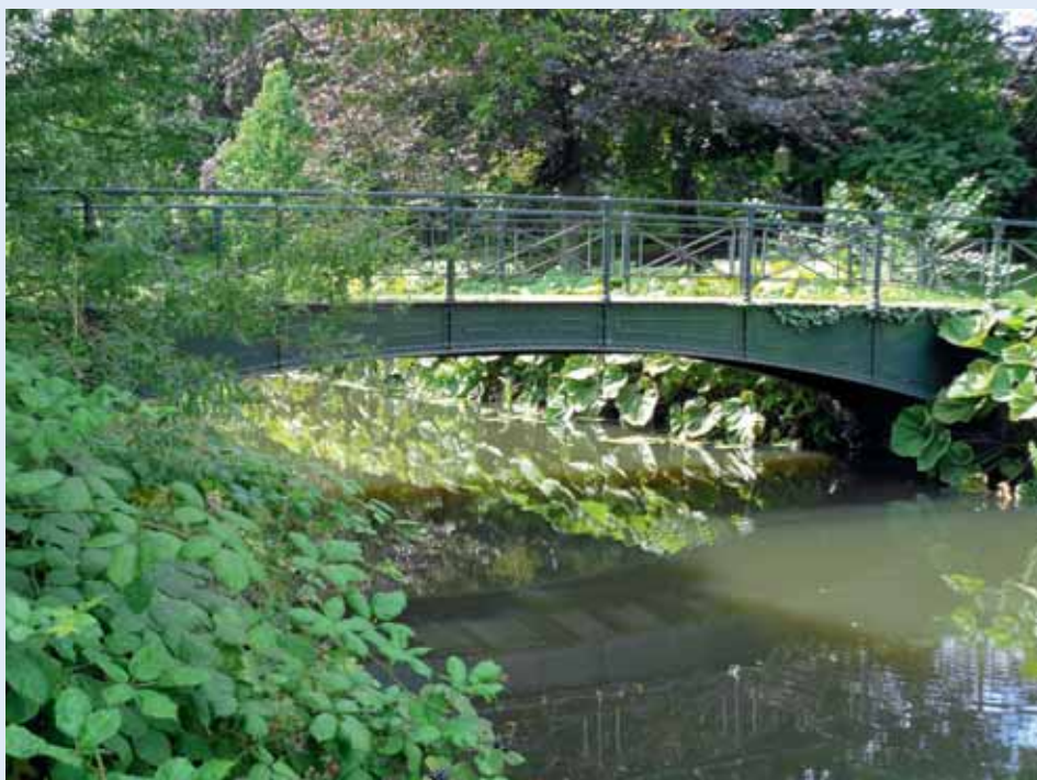
3 Gietijzeren brug over de Beek – gebouwd in 1902, een groene brug in een dito omgeving
