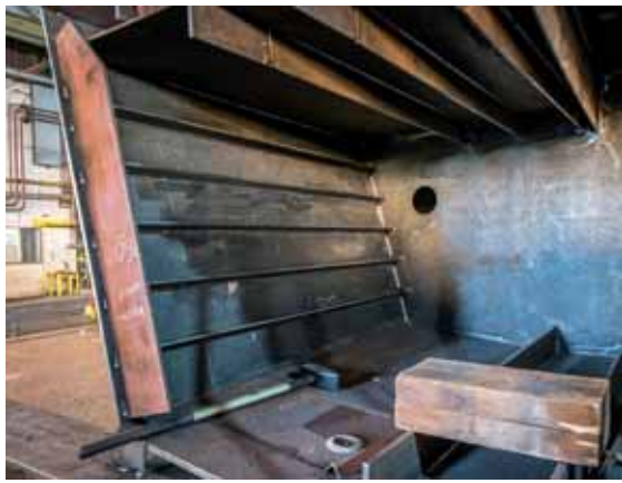
← 7 Inrijke kokerligger in aanbouw ©Fotografie Arie Mastenbroek, Zaltbommel.
