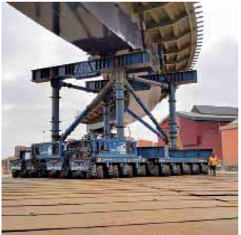
Viaduct, gereed voor transport
