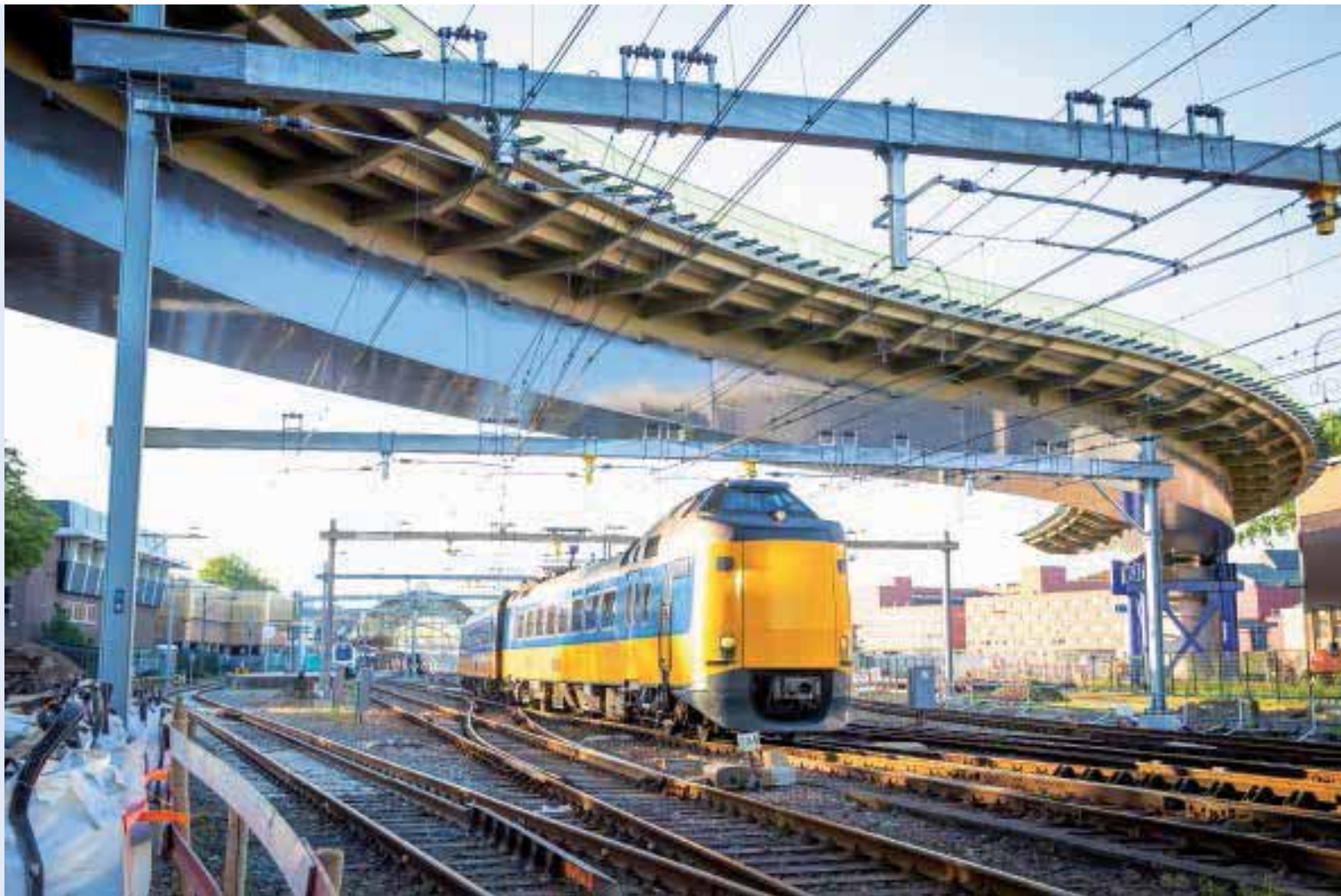
Tijdelijke steunpunten buiten het spoor busbrug Zwolle.
