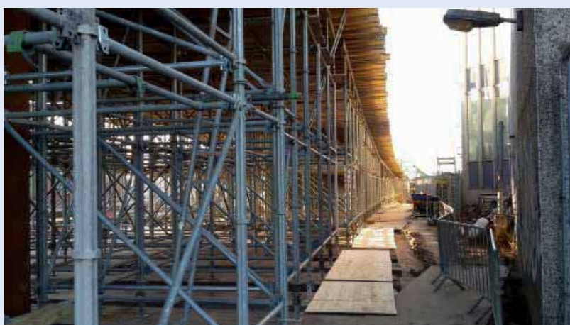
Bekistingsconstructie betonnen aanbrug
