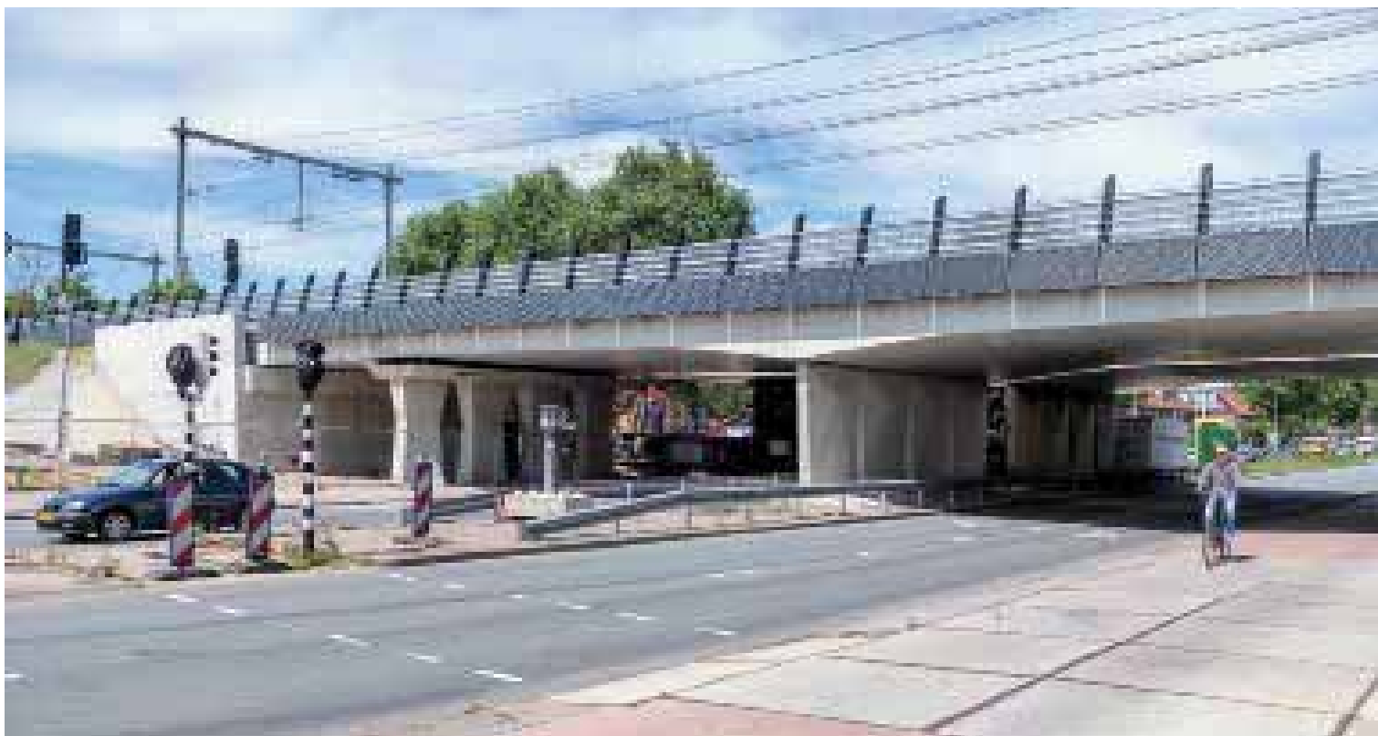
Spoorviaduct Cartesiusweg, Utrecht
